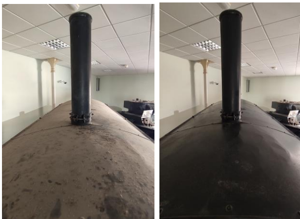
Figura 3. Cubierta de la pieza. Izquierda: estado inicial; derecha: resultado final tras la limpieza
