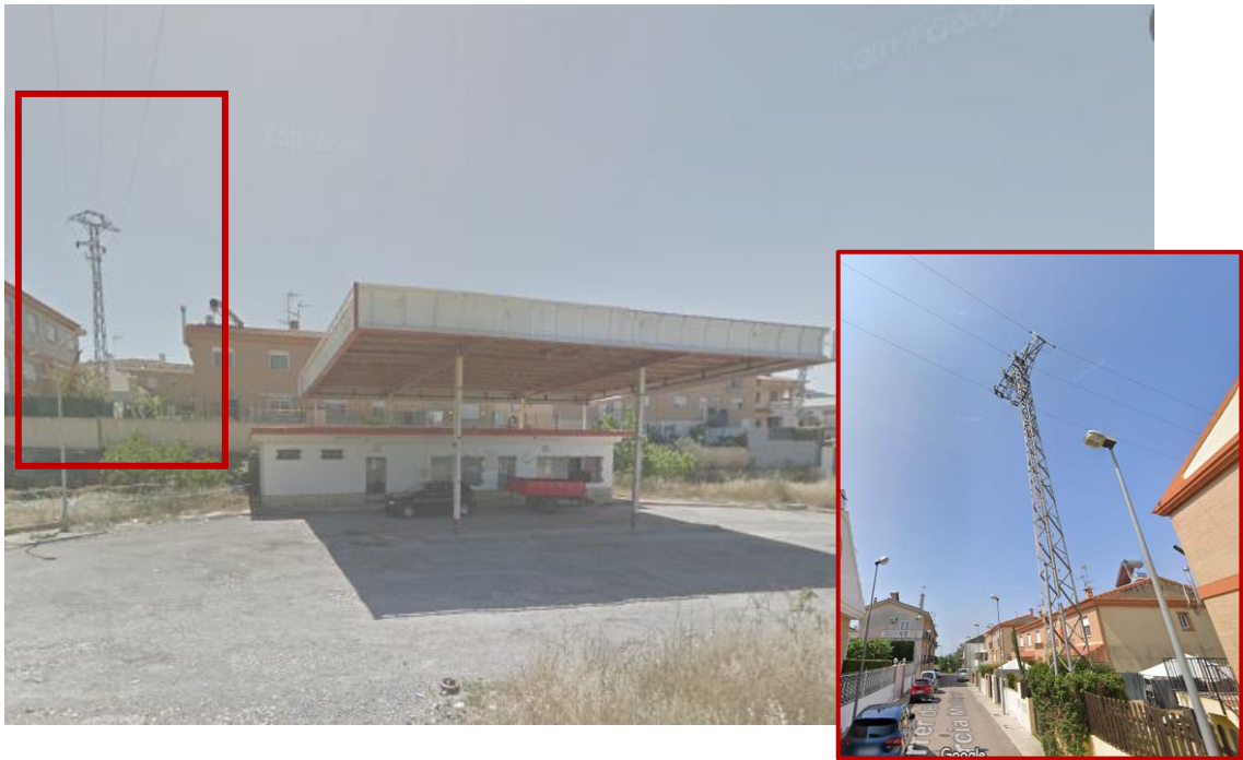
Ilustración 21. Torre de media tensión próxima a la estación
