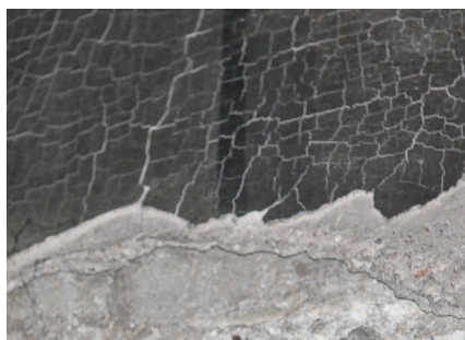
Figura 28 (Izquierda). Fotografía detalle de craqueladuras direccionales.
