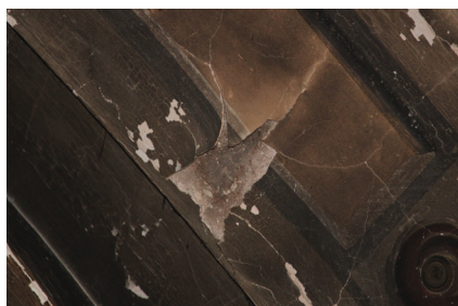
Figura 51. Levantamientos de la película pictórica y del enlucido de preparación.
