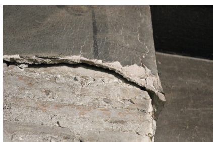
Figura 52. Estratos separados del soporte mural.
