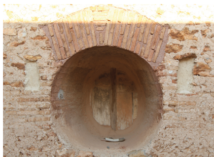
Figura 34. Fotografía de una de las ventanas selladas que dan al exterior.
