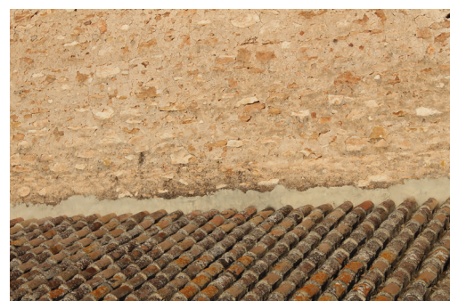
Figura 32. Fotografía de la cubierta del trasagrario.
