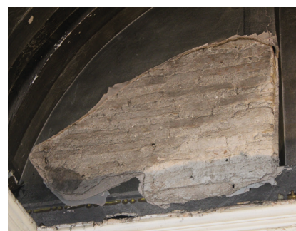
Figura 26 (derecha). Pérdida de la película pictórica y de estratos preparatorios.
