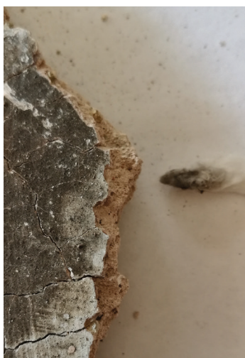
Figura 14. Prueba de resistencia al aporte de humedad.
