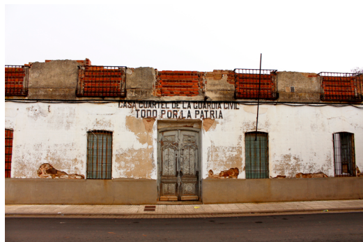
Fig. 4 Antiguo cuartel de la Guardia Civil
