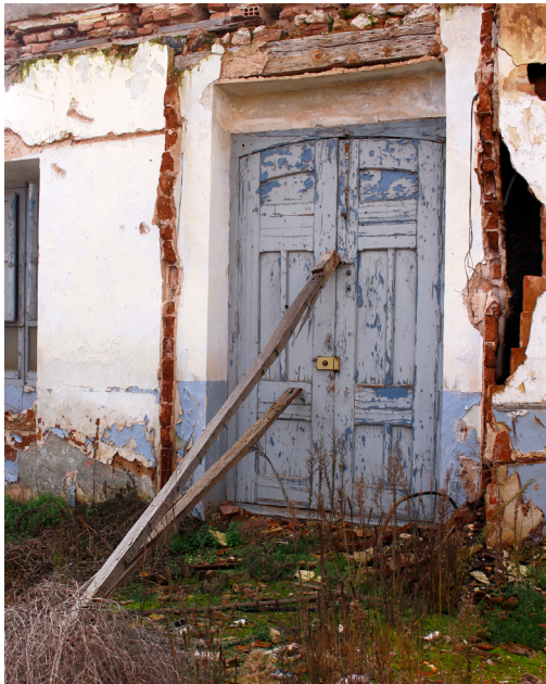
Fig. 35 Viguetas de madera
