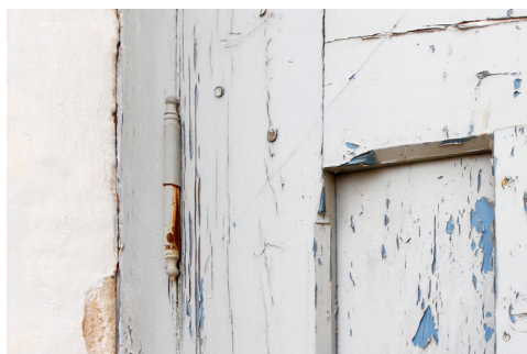
Fig. 36 Bisagra oxidada
