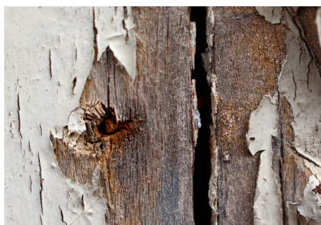
Fig. 9 Detalle clavo que une dos piezas
