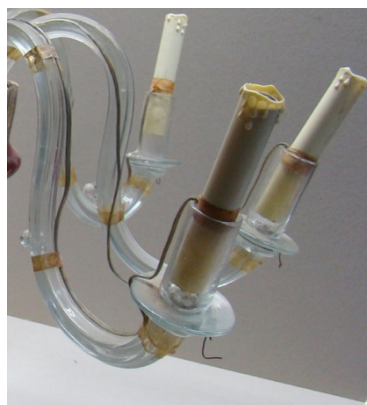
Fig. 72. Detalle del cableado sujeto con cinta adhesiva
