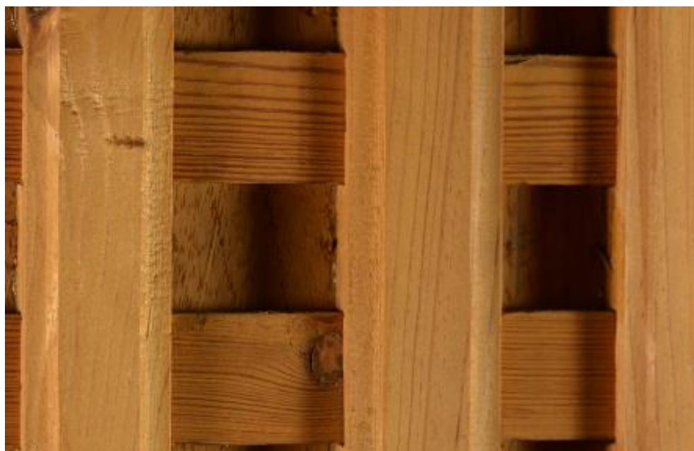
Fig. 13. Fotografía de detalle de la obra objeto de estudio: engatillado.
