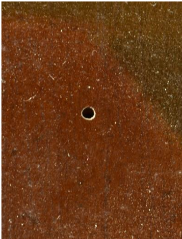
Fig. 20. Fotografía d detalle de un orificio causado por ataque xilófago.
