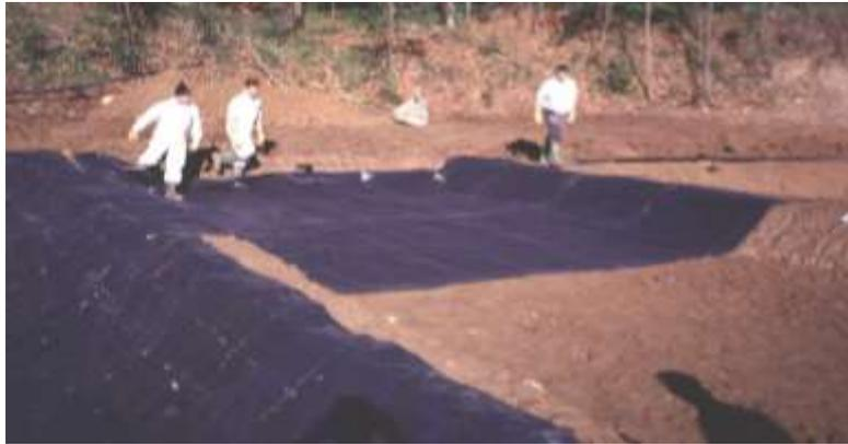
Figura 65. Operaciones de colocación de una geomembrana en un humedal artificial. Tomada de (García Serrano y Corzo Hernández, 2012)
