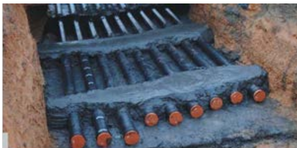
Figura 2. Hormigonado con 12 cables entubados.
