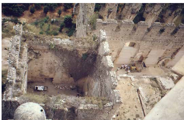
Fig. 9. Vista aérea de los restos del aula capitular, refectorio y claustro del monasterio de Santa María de la Valldigna. (Valencia, España). Fotografía: E. Capilla. 23 -7-1997.
