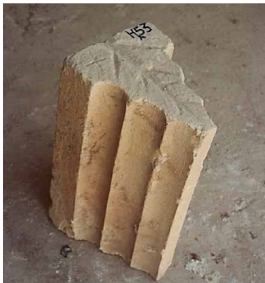
Fig. 20. Vista de una de las dovelas tipo HA, formada por tres esgucios o medias cañas y la base rectangular, perteneciente a los terceletes y ligaduras de la bóveda estrellada del aula capítular del monasterio de la Valldigna. (Foto: Esther Capilla. 1997)
