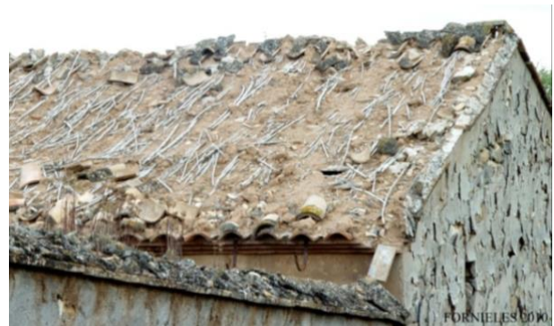
Figura 10. Restos de las cañas empleadas como relleno. Este es el aspecto que presenta el edificio nuevo del Mas del Baixó tras el expolio de materiales sufrido en 2010.
