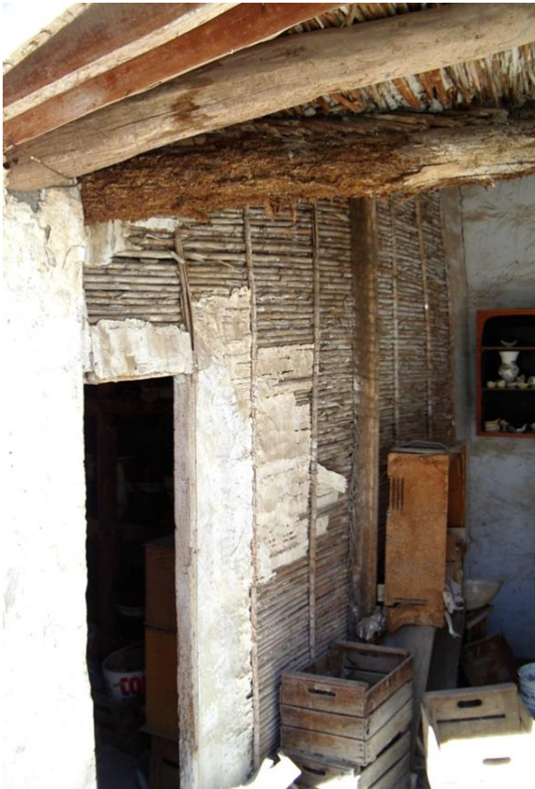
Figura 9. Barandat en una caseta de huerta formado por caña gruesa donde se aprecian los cabirones verticales, los pilares de montaje y restos del enlucido de yeso
