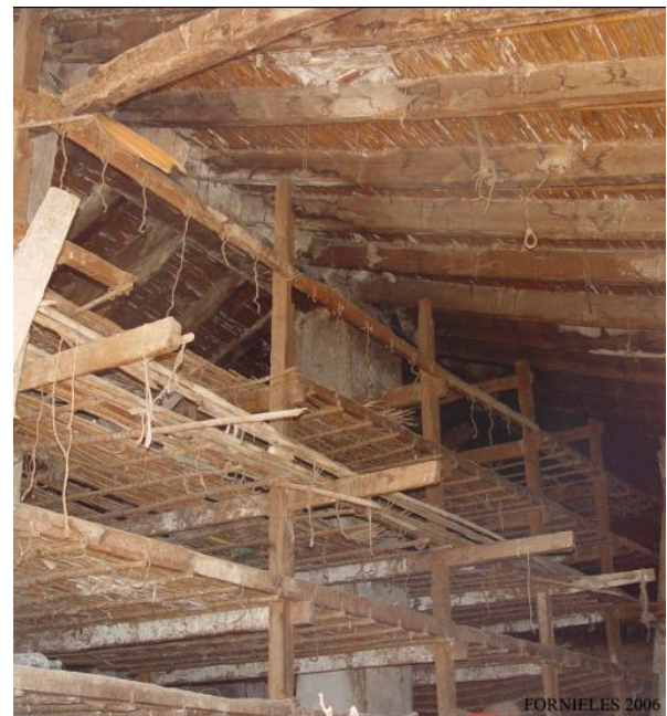
Figura 6. Cubierta de caña y secador de la cambra hecho con madera y caña. Se trata del edificio primitivo del Mas del Baixó
