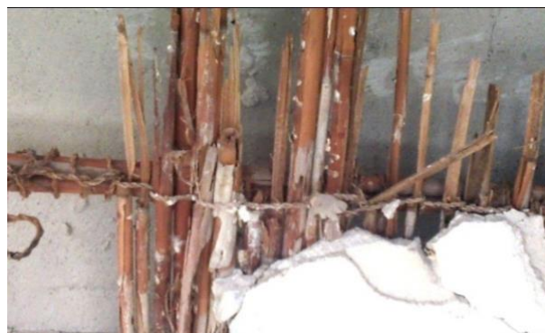
Figura 4. Unión de pilar, caña y yeso
