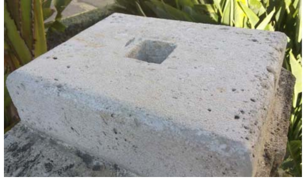
Figura 16. Vista del plinto con el hueco de ensamble limpio.
