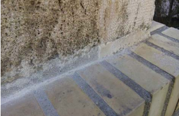
Figura 18. Detalle de la fase de limpieza del mortero de junta inadecuado.
