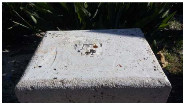
Figura 7. Vista general del plinto donde descansaba la escultura. Obsérvese en la parte central la presencia de una pieza encastrada de mortero con una espiga metálica en su interior.
