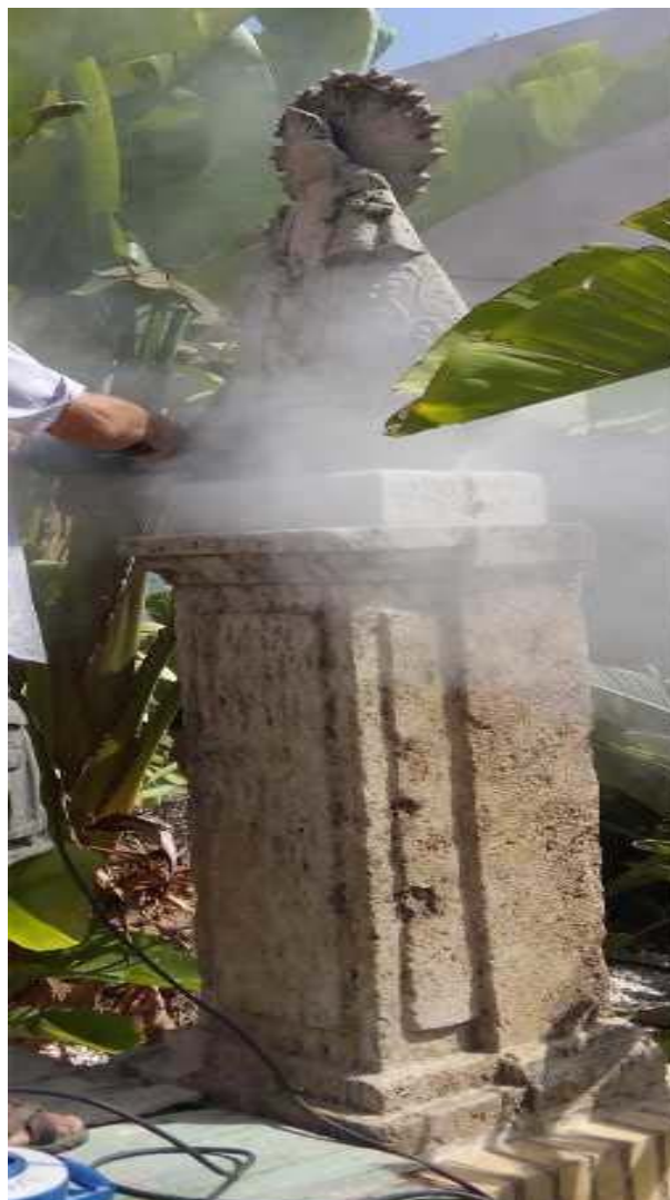
Figura 6. Fase inicial de corte con disco diamantada que permitirá la separación de la pieza del pedestal.
