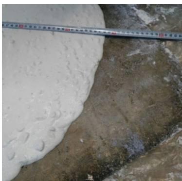
Figura 5. Frente de avance del HAC
