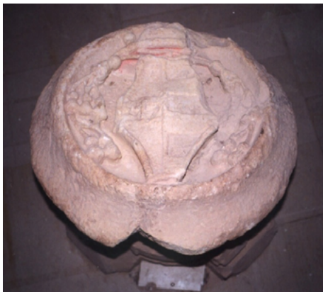
Figura 7. Clave de terceletes de la bóveda de la sala capitular del monasterio de la Valldigna (Valencia), con restos de color. (Foto: Esther Capilla)
