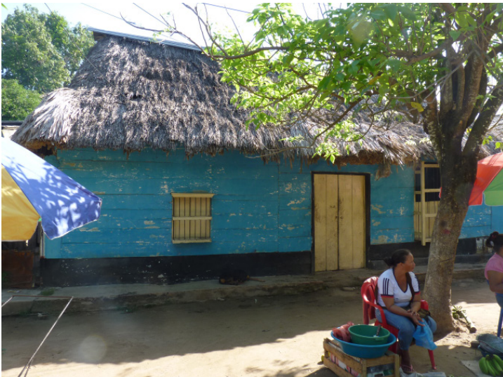
16. Imagen de inmueble propio de la arquitectura popular de Mompós. Existen en la actualidad pocos casos de viviendas con teco pajizo y muro de bahareque.
