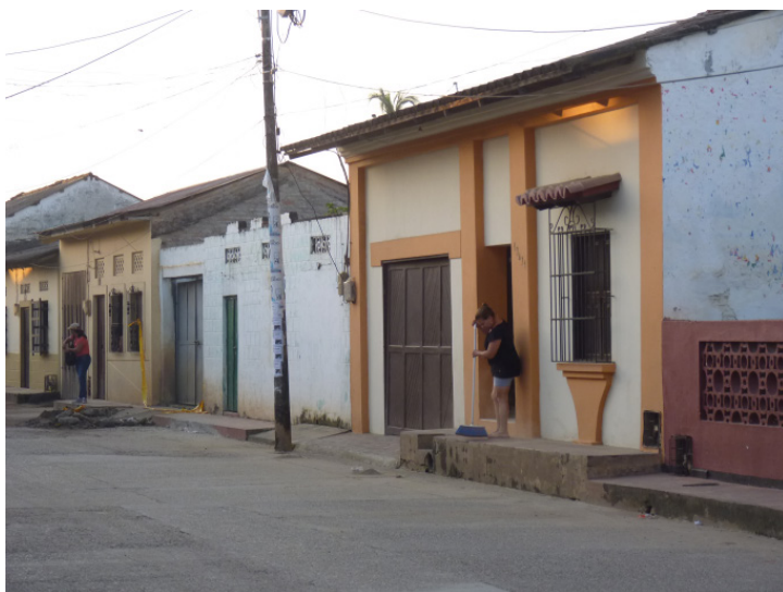
14. Imagen del tramo de la Calle Real del Medio al sur del Templo de Santa Bárbara.
