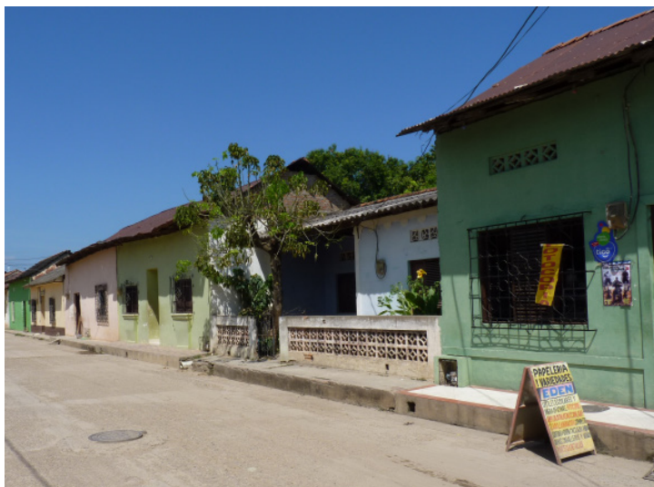
15. Imagen del tramo de la Calle Real del Medio al sur del Templo de Santa Bárbara.
