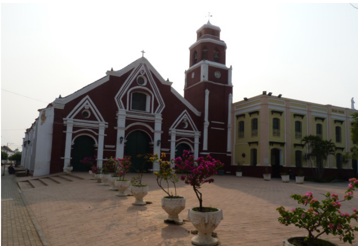
21. Imagen de la fachada del Templo de San Francisco. Plaza de San Francisco.
