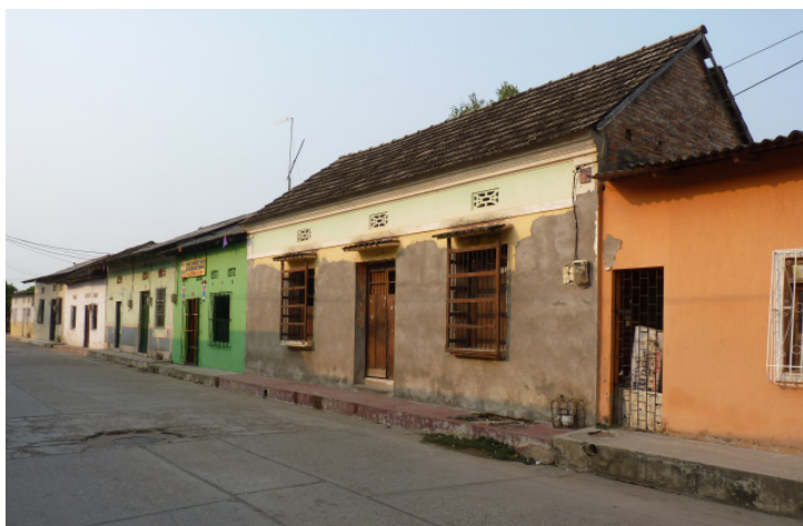
56. Ejemplo de inmueble localizado en la Calle Real del Medio a partir de la Iglesia de San Francisco.
