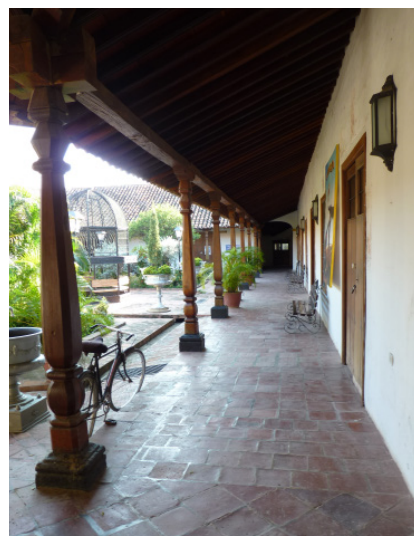
30. Imagen de pies derechos característicos en la arquitectura del centro histórico de Mompox.
