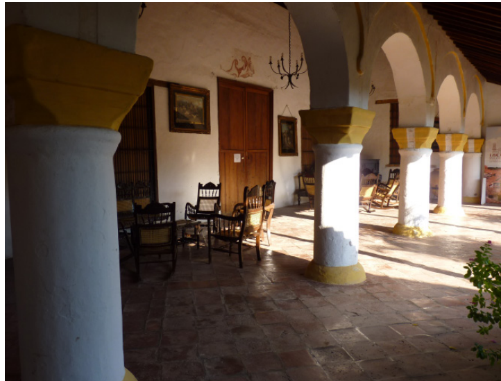
47. Ejemplo de línea de pilares en mampostería en doble crujía en inmueble del centro histórico de Mompox.
