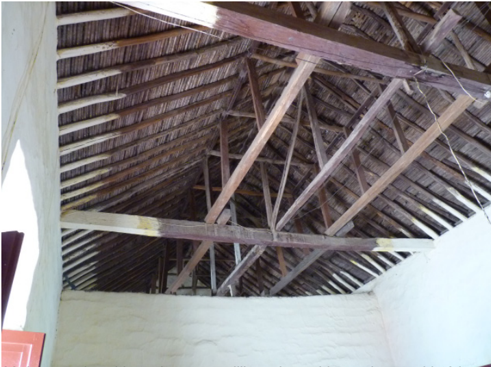
36. Imagen de cubierta de par y nudillo en inmueble en el centro histórico de mompox.
