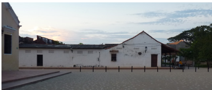
60. Perfil tradicional en inmuebles en esquina en el centro histórico de Mompox.
