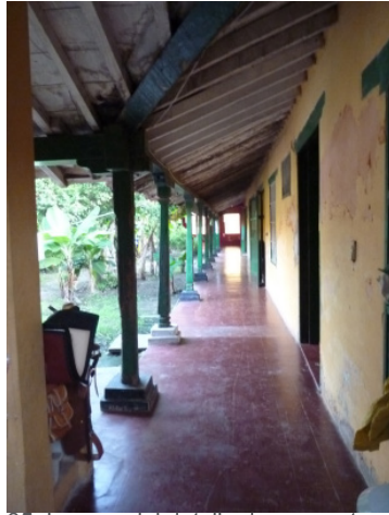
35. Imagen del detalle de encuentro de pies derechos y vigas en galería.
