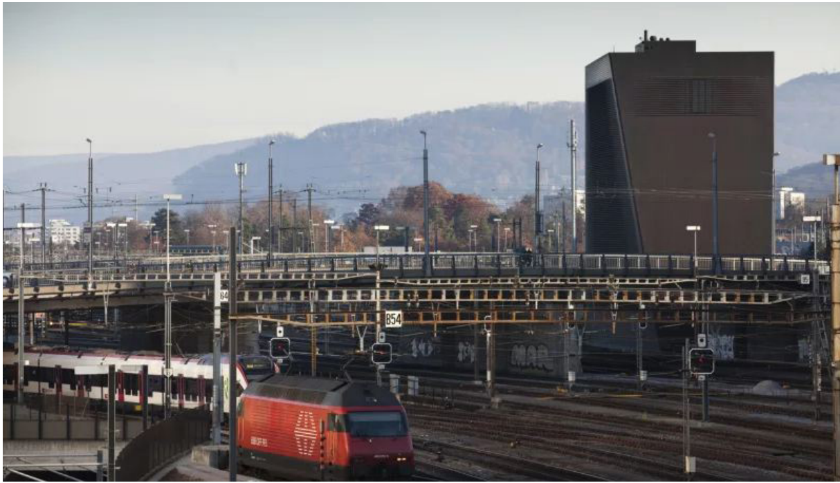
Img.10 Central de Señalización
