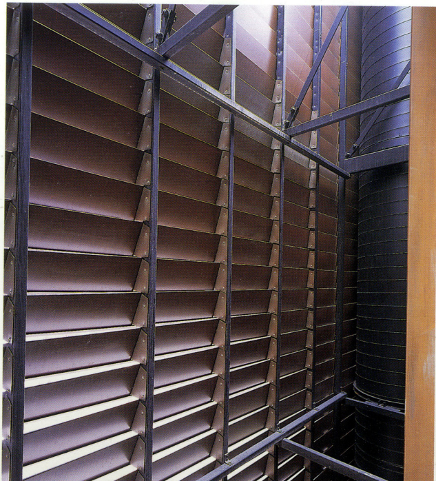
Img. 36 Fotografía interior: Detalle de torsión
