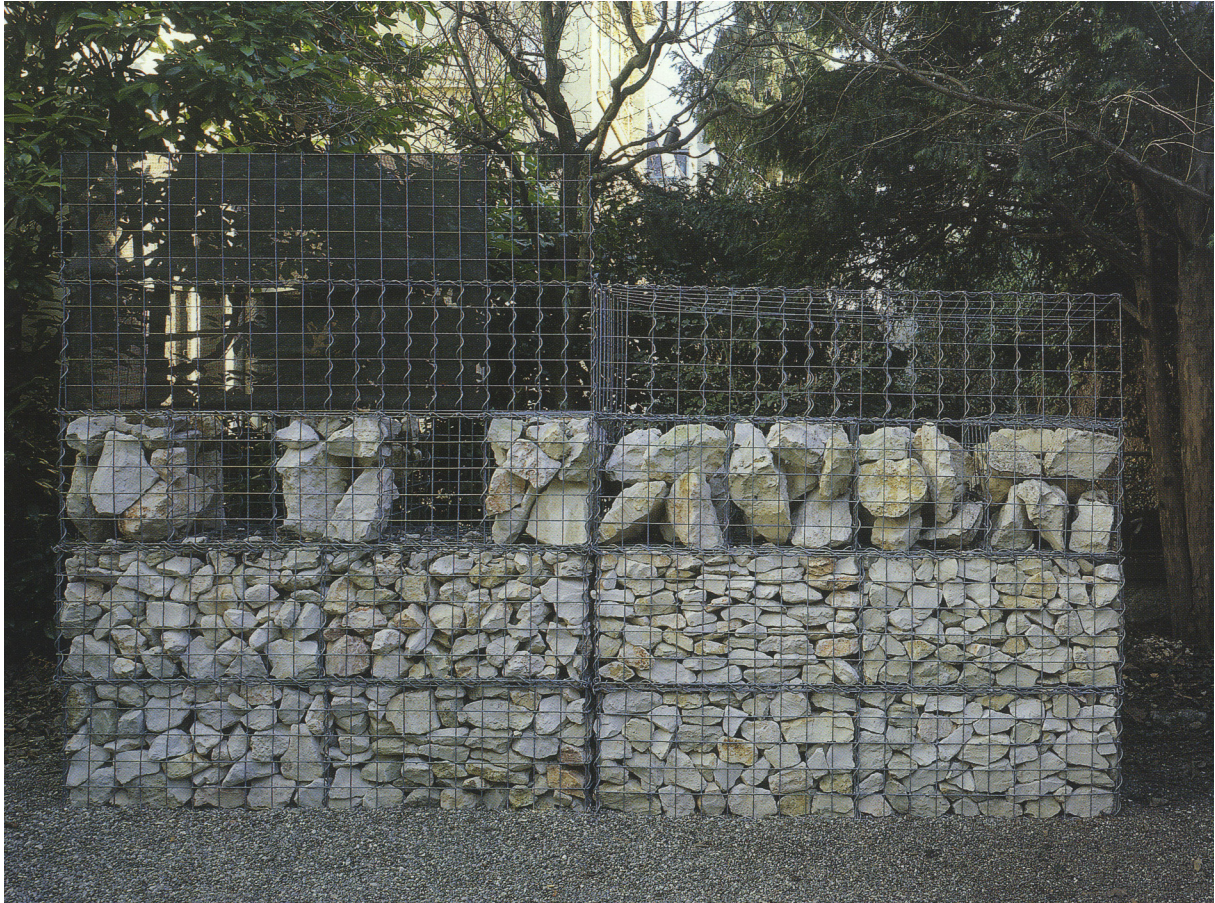
Img. 24 Pruebas de fachada 1
