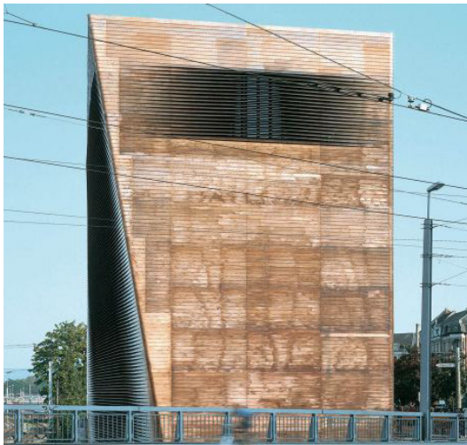
Img. 32 Fotografía exterior
