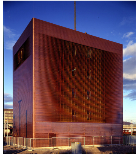
Img.29 Fotografía exterior Signal Box 4
