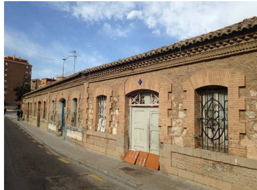
Figura22. Grupo viviendas Ramón de Castro en la actualidad.
