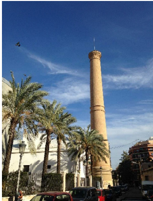
Figura 40. Chimenea fábrica térmica 'La Valenciana'
