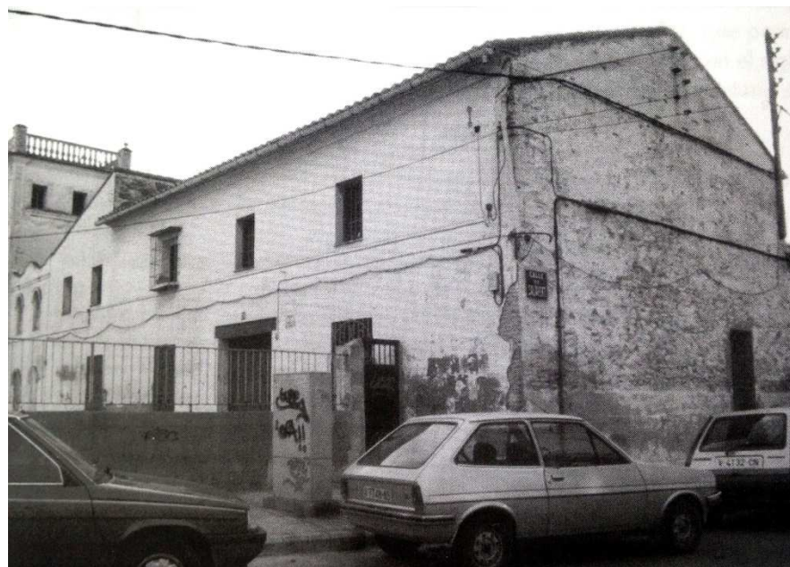
Figura 9. Alquería de Salavert antes de su derribo.
