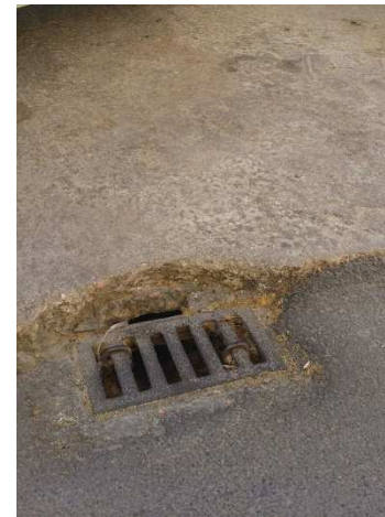
Figura 68. Evidencia paso acequia de Favara.
