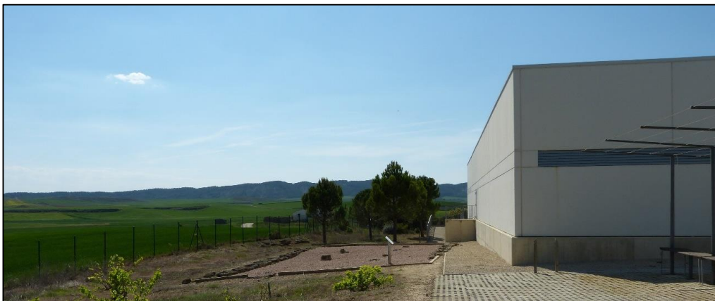
Figura 2.5. Cubierta del año 2008 de hormigón armado y elementos metálicos que protege las estancias más representativas de la villa romana de La Musas (Arellano, Navarra).
