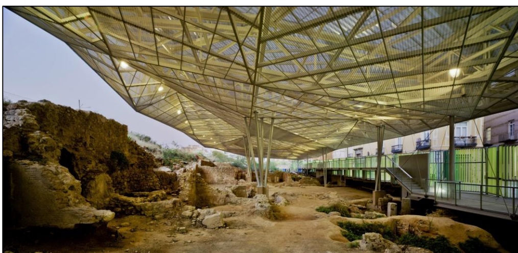
Figura 2.17. Colocación de una cubierta de policarbonato y chapa perforada en el Parque Arqueológico del Molinete (Cartagena, Murcia) entre los años 2008 y 2012. Fuente: D. Frutos y A. Cánovas Maruri.
