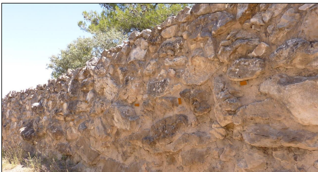
Figura 2.38. Reconstrucción de la muralla del poblado íbero en la Bastida de Les Alcusses (Moixent, Valencia), con materiales y técnicas afines y originales. Se distingue la colocación de testigos de chamota como diferenciadores entre originales y añadidos.
