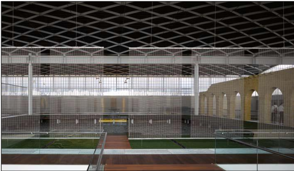
Figura 2.24. Colocación de mallas de tejido metálico como marcadores de estructuras y separadores de los espacios. Fuente: García de Paredes y G. Pedrosa.
