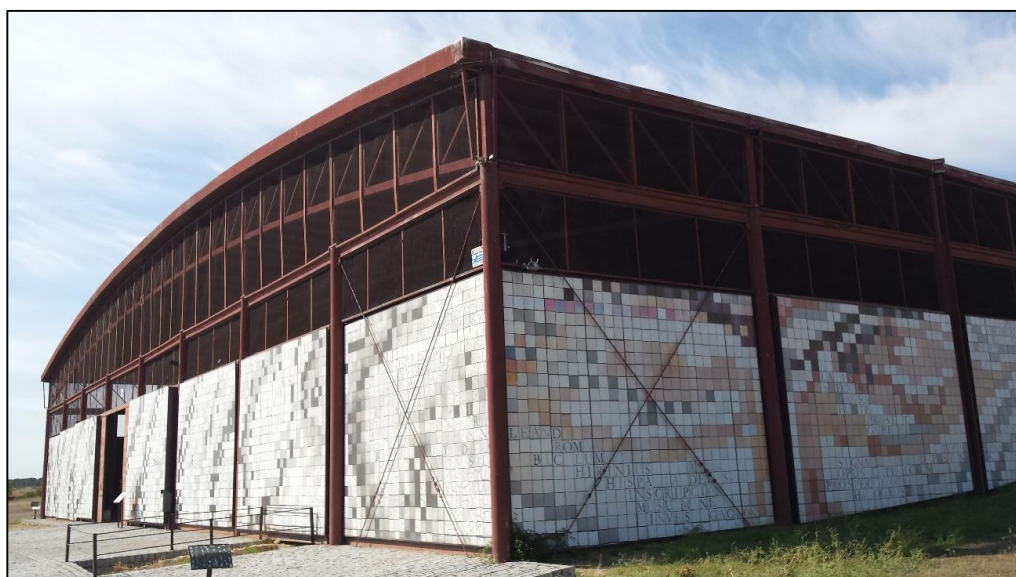
Figura 2.4. Cubierta metálica del año 2010 que cubre la Casa de Materno, origen de la Villa romana de Carranque (Toledo).
