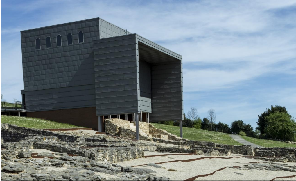
Figura 2.18. Nueva cubierta de zinc en la Villa romana de Veranes (Gijón, Asturias) del año 2015.
