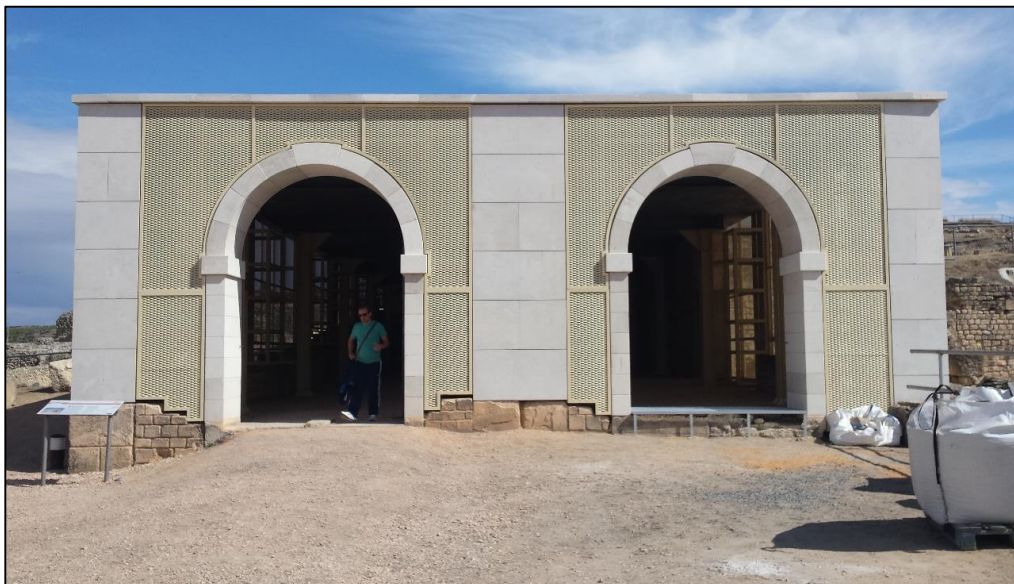
Figura 2.20. Colocación de una cubierta metálica y de hormigón en el año 2015 que muestra el volumen y forma original hipotética de los restos del Criptopórtico del foro de Segóbriga (Saelices, Cuenca).
