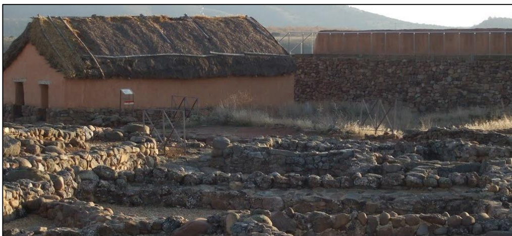
Figura 2.40. Vivienda celtibera reconstruida a partir de técnicas originales en el yacimiento de Numancia (Garray, Soria) en 1994. Fuente: Choiva n.d.
