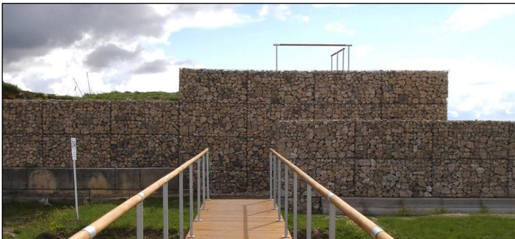
Figura 2.14. Reconstrucción volumétrica parcial de restos arqueológicos en Clunia (Peñalba de Castro, Burgos) utilizando como medio común los gaviones. Proyecto del año 2007. Fuente: A3GM Estudio de Arquitectura.
