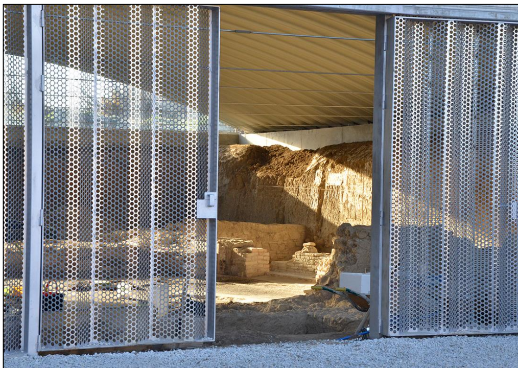
Figura 2.9. Cerramiento metálico en la Villa Romana del Salar (Granada). Fuente: Davila Fortress.
