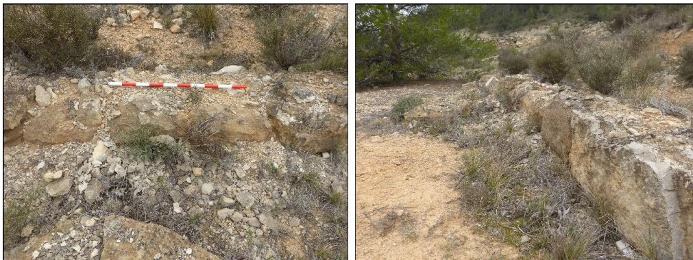
Figuras 3.62. Desprendimientos en forma de lascas de los elementos pétreos.
