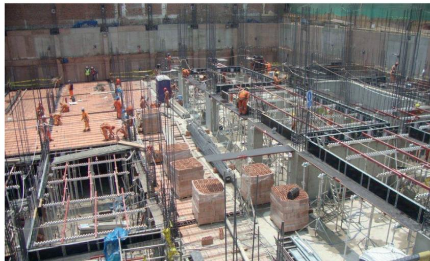
ENCOFRADO DE VIGAS DE CUELGUE CON MECANOFLEX
