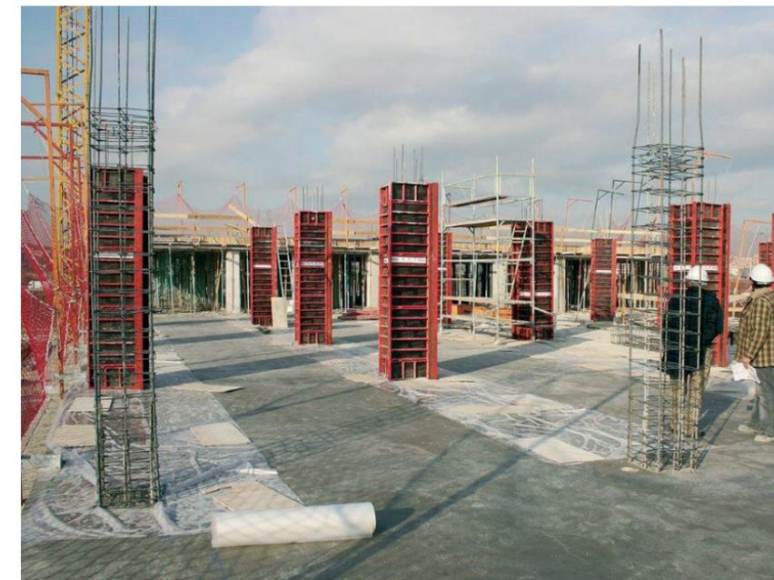
ENCOFRADO DE PILARES CON ALISPILAR
