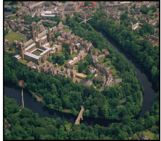
Imagen 10. Vista Aérea del centro histórico de Durham
