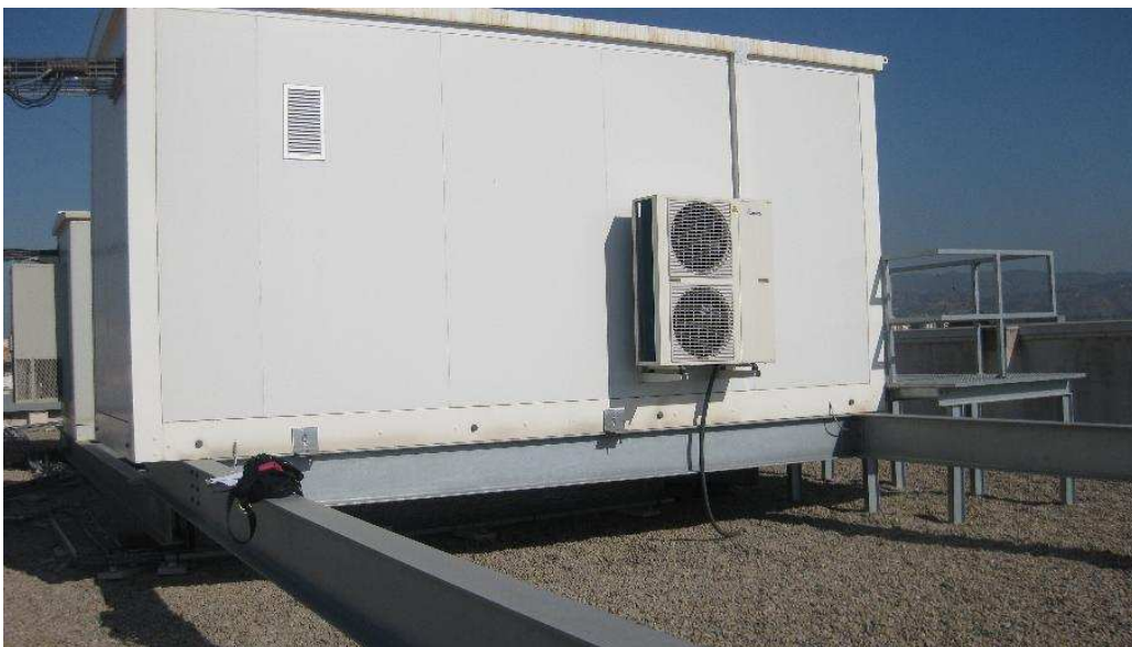
Instalación de la caseta
