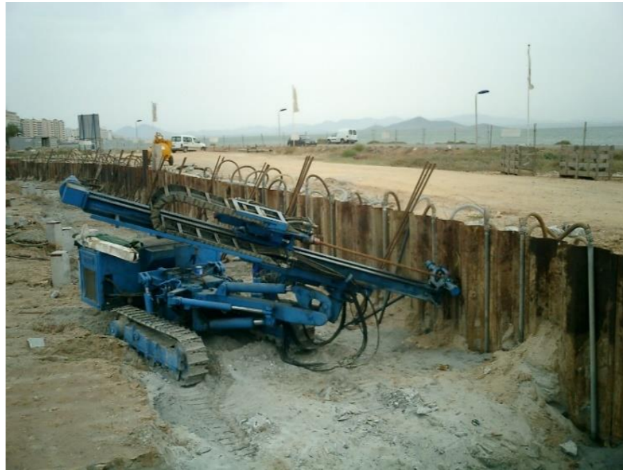
Ilustración 38: Carro para ejecución de anclaje. Fuente: Empresa Ischebeck Ibérica.
