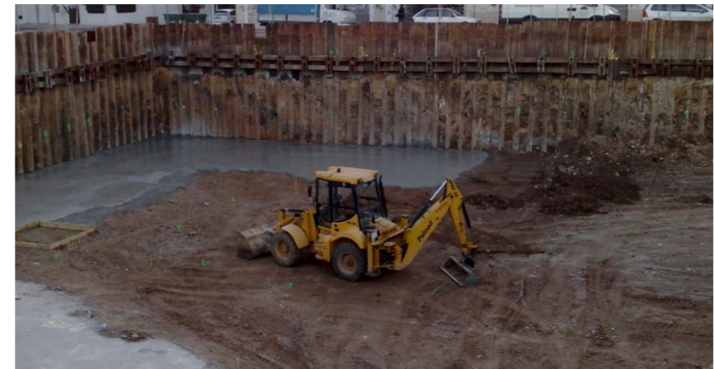
Ilustración 41: Retroexcavadora. Fuente: Ischebeck Ibérica.
