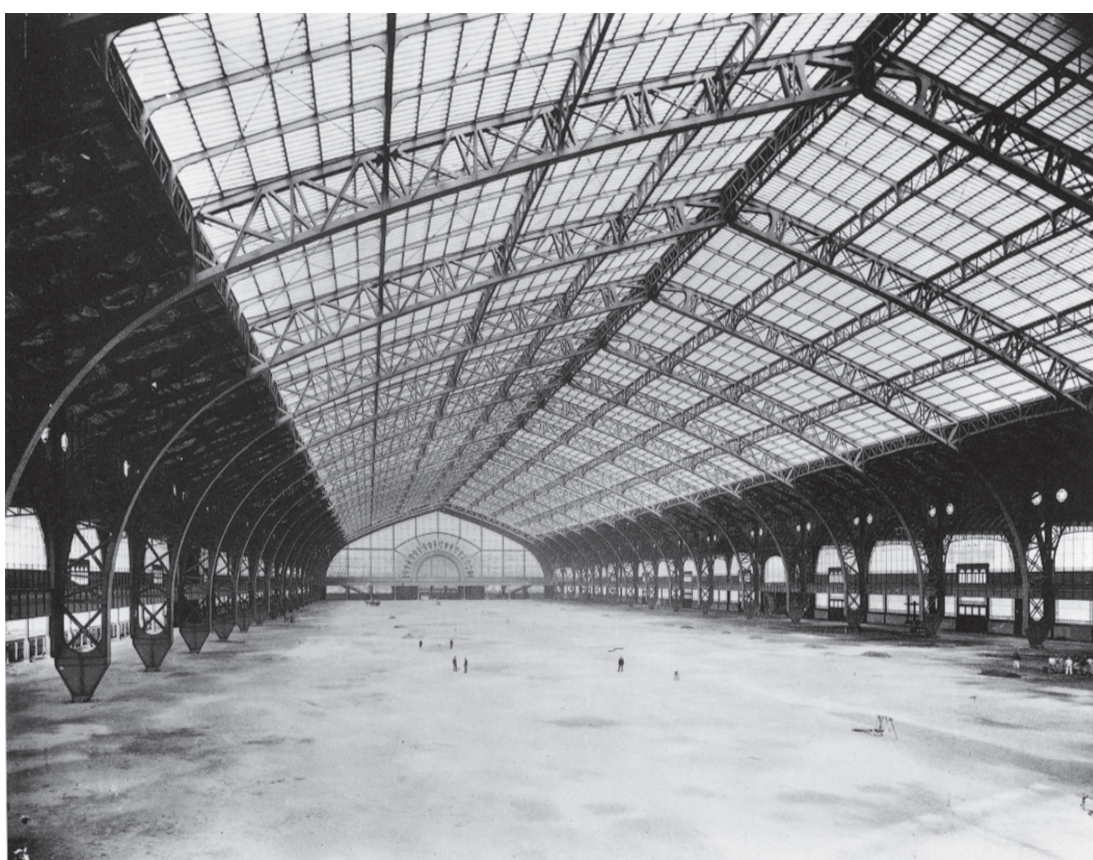
Figura 5. Gran espacio interior de la nave central del Palais des Machines de París de 1889.
