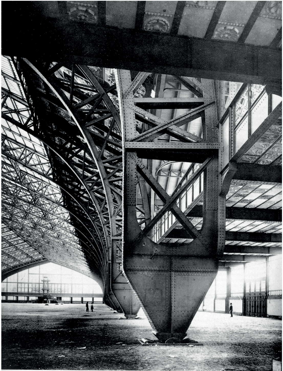
Figura 7. Imagen del apoyo del pórtico sobre la articulación inferior.
