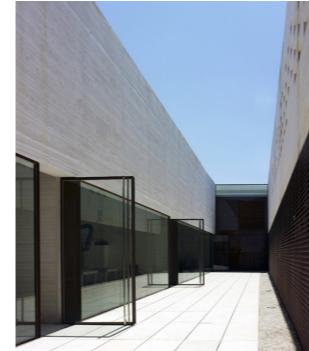
Cerramiento exterior hormigón visto Museo Medinat Al Zahara, Nieto Sobejano, Arquitectos
