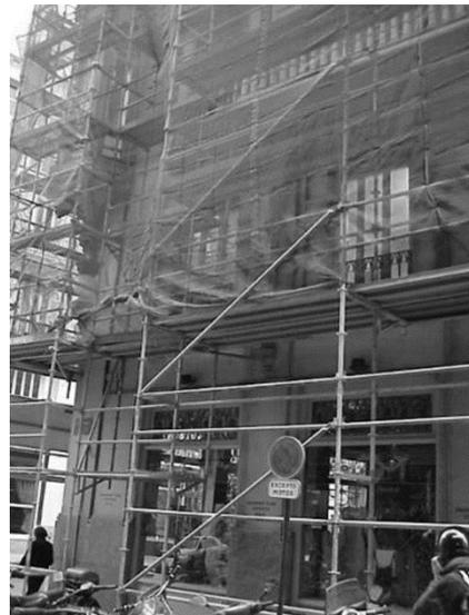
**MARQUESINAS O VISERAS:** Protecciones colectivas a terceros, no usuarios del andamio, pero sí de su entorno, frente al riesgo de caída de objetos al vacío desde las zonas de trabajo en el interior del andamio. Normalmente los sistemas prefabricados disponen de piezas especiales para la construcción de marquesinas sobre el propio andamio.
