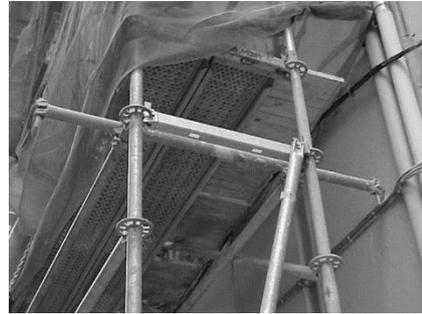
El número de anclajes se calculará en función del esfuerzo de viento que soporte el andamio, según su emplazamiento geográfico, urbano y la altura total de la estructura. Será determinante en este cálculo la circunstancia de que el andamio lleve o no en su instalación lona de protección. De llevarla, el esfuerzo que deberá soportar el andamio, y por tanto sus anclajes, será mayor.
