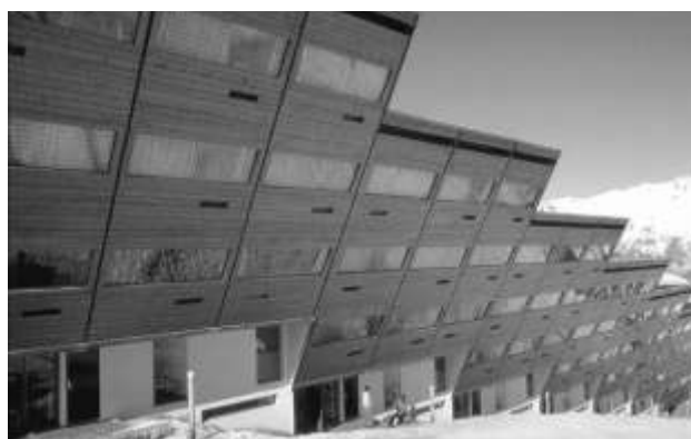
[32] Les Arcs , Arc 1600. Residencia de la Cascada, Rey-Millet, Charlotte Perriand, 1969
