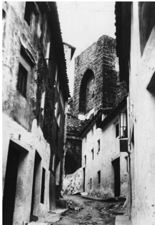
fig. 19.- Torre Norte (interior). 1953
