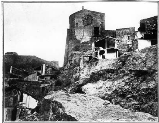
Estado en que ha quedado la parte superior del castillo de Bañol. Fig. 33a.
