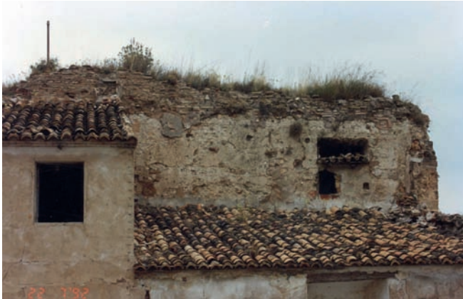
fig. 78.- Viviendas c/del Castillo. 1993
