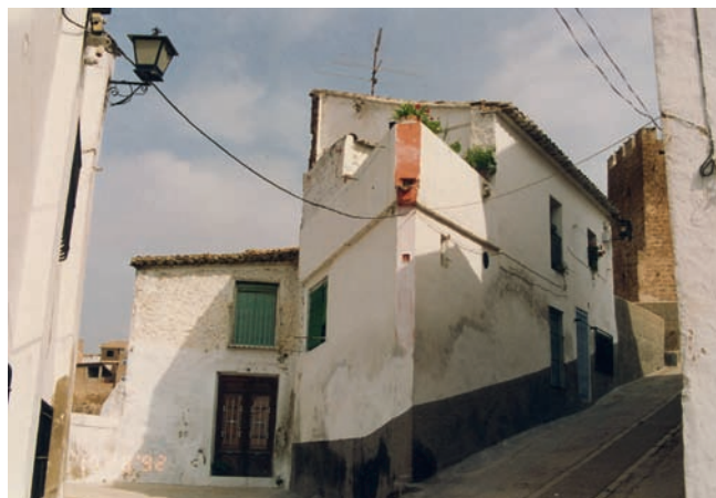
fig. 49.– Viviendas Calle del Castillo. 1993
