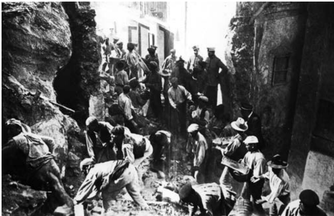
fig. 34.- Desplome 1911. C/ Huerto del Castillo. Desescombro
