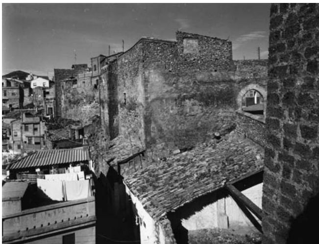
fig. 30.- 1983. "Corral de Abril" durante la Demolición.
