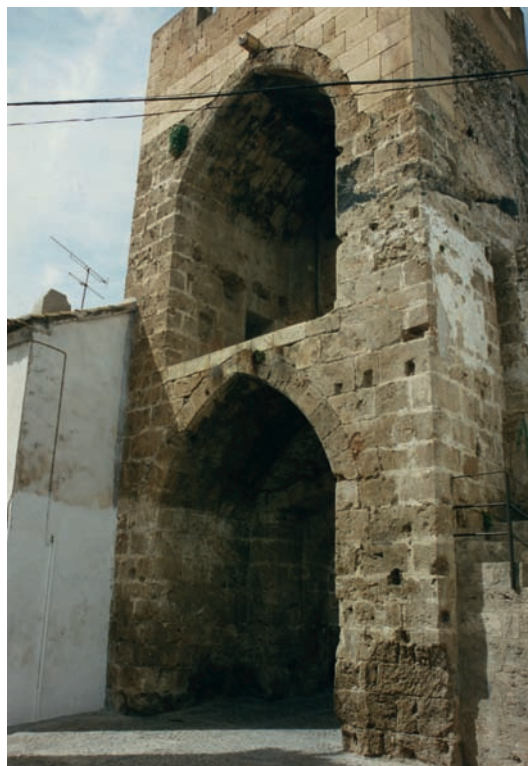
fig. 14.- Torre Norte. Vista Interior
