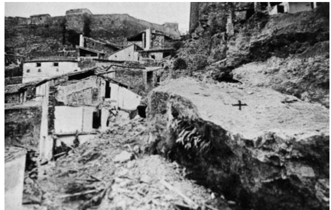
fig. 36.- Desplome 1911. Roca caída
