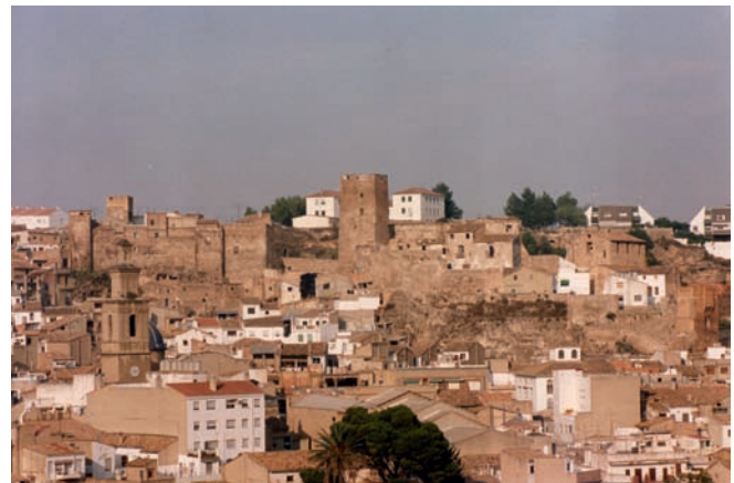
fig. 4.- Vista General Oeste. Plaza de Armas
