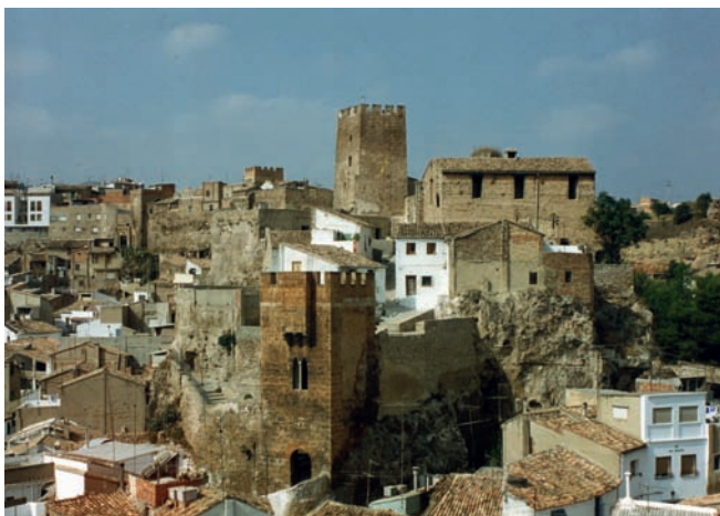
fig. 31.- Conexión Fortaleza Sur y "Torreta"
