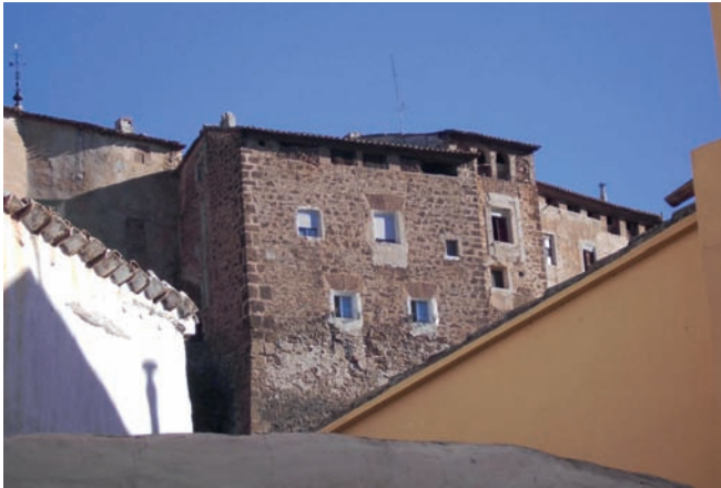
fig. 42.– Casa Palacio. Chelva. General
