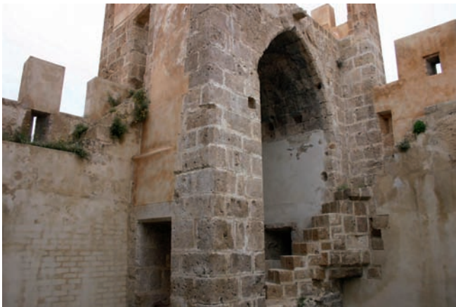
fig. 35.- Torre Noreste. Escalera y Paso de Guarda
