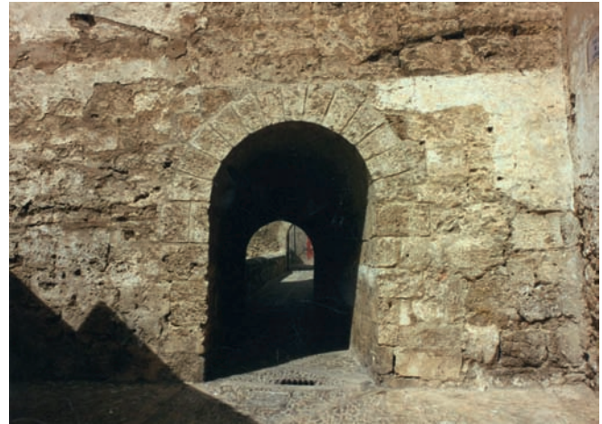
fig. 59.– Torre del Homenaje. Túnel.
