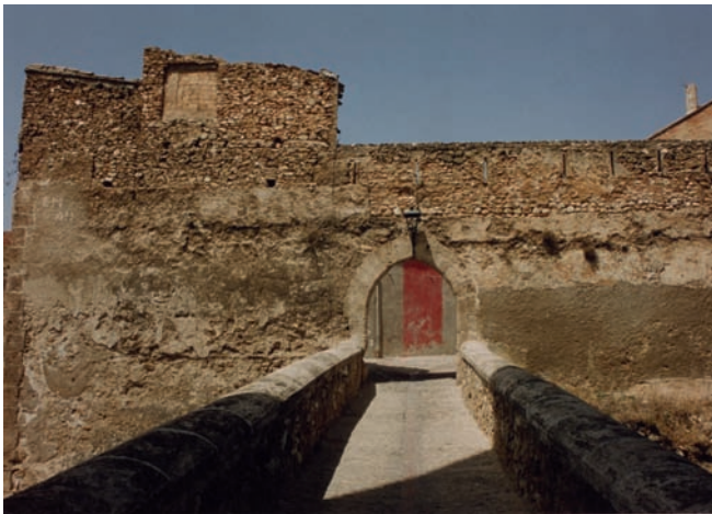
fig. 8.- Acceso Sur a través del Puente Central
