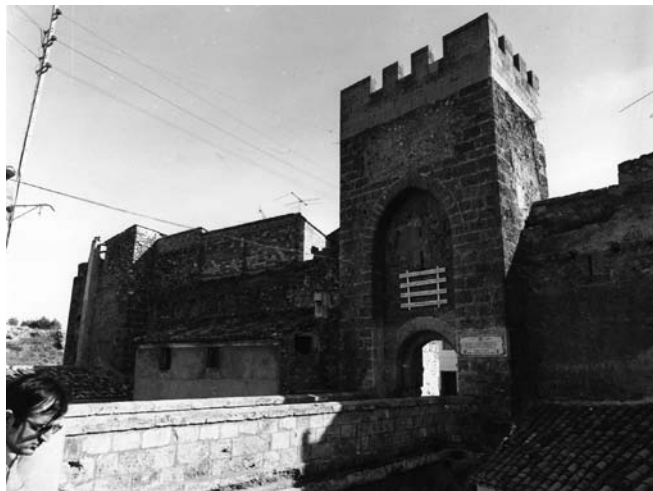
fig. 15.- Torre Norte. Reconstrucción Almenas. Foto 1975
