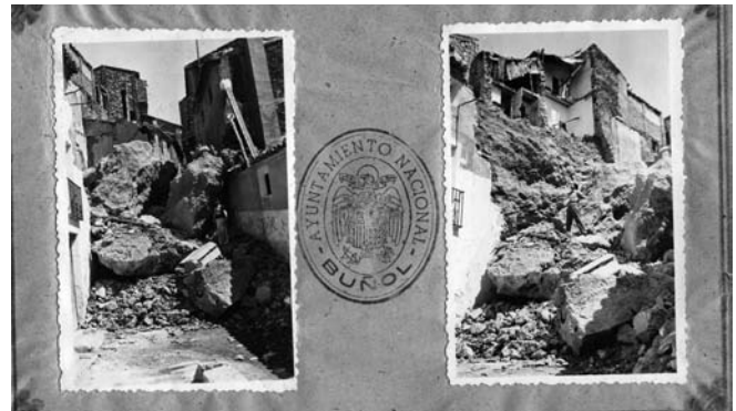
fig. 4.- 1941. Fotografías del Derrumbe
