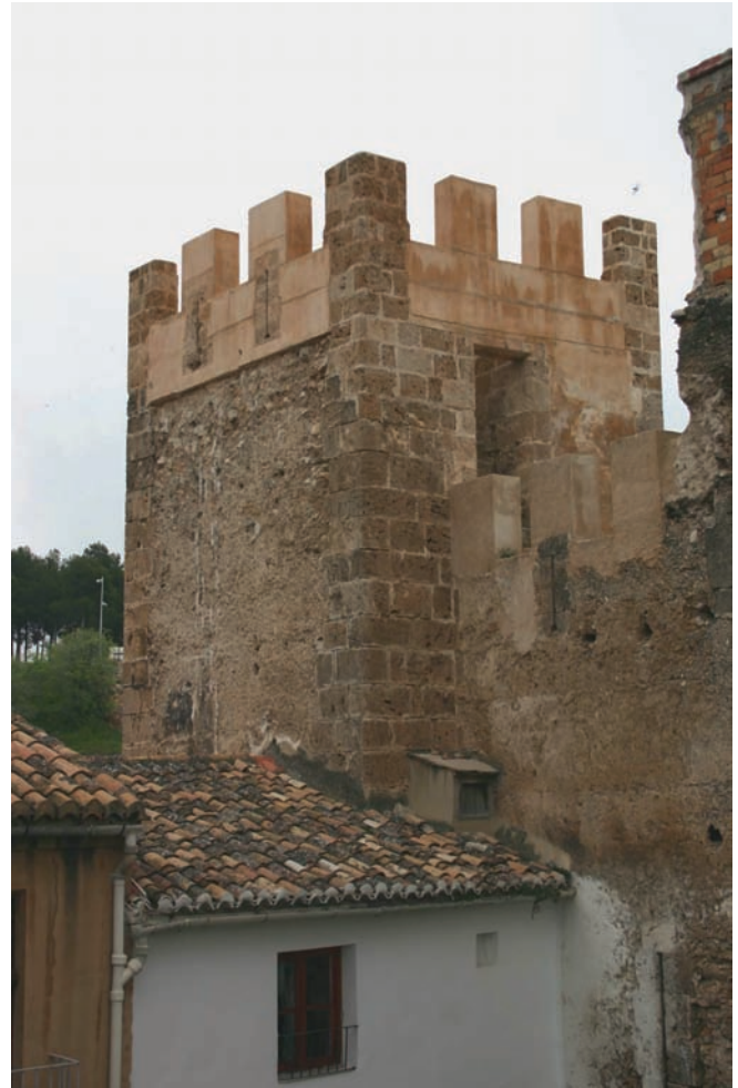
fig. 36.- Torre Noreste. Restauración Merlones
