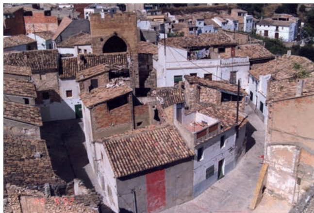
fig. 6 Vista aérea Plaza de Armas antes del derribo
