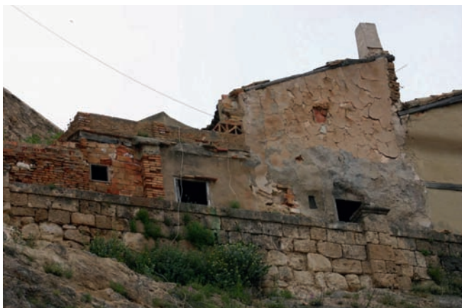
fig. 38.– Medianerías de 1911. Estado Actual
