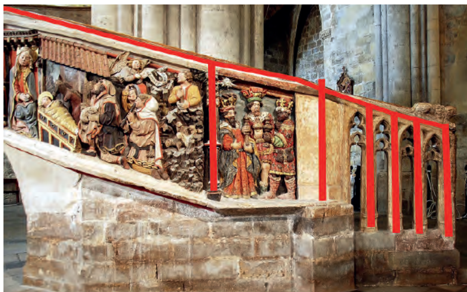
Fig. 4. Arranque de la escalera con indicación en color rojo de los elementos metálicos identificados en ese tramo.
