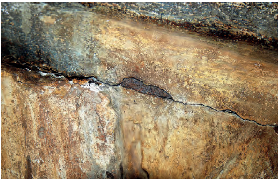
Fig. 6. Detalle del pasamanos de la escalera, a la altura del cuarto peldaño, donde emerge una pletina metálica del entramado estructural que la recorre hasta el desembarco.
