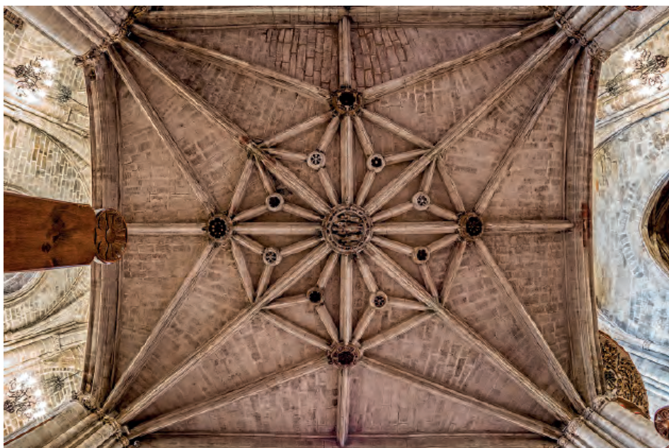
Fig. 2. Vista cenital de la bóveda del coro de Morella (foto de Carlos Martínez 2015)
