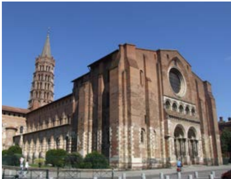
Imagen 27. Fachada occidental, tras la Des-restauración, Actualmente.
