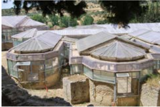
Imagen 50. Villa Romana del Casale, tras la Restauración de Minissi, 1958, Cobertura de vidrio y plexiglás.
