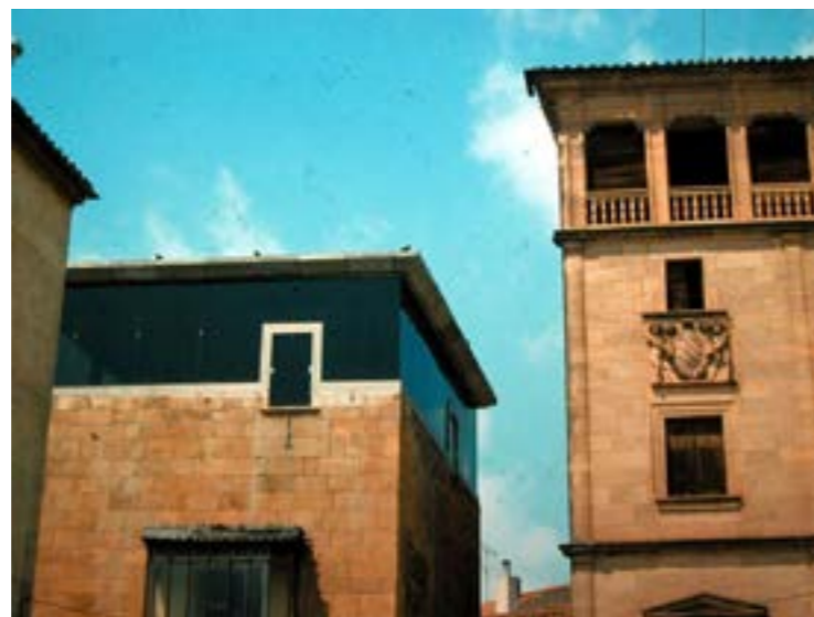
Imagen 45. Parte superior de la Torre de los Lujanes, tras la Restauración, 1974.
