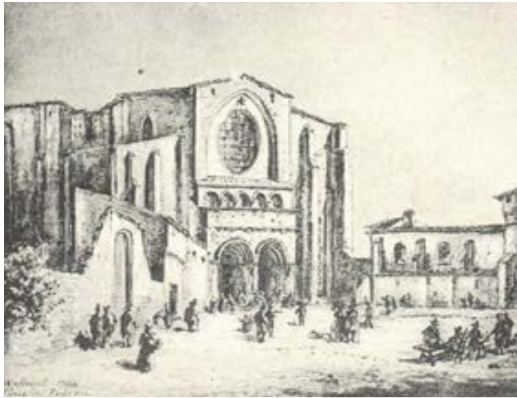
Imagen 25. Grabado de la fachada occidental, 1760.
