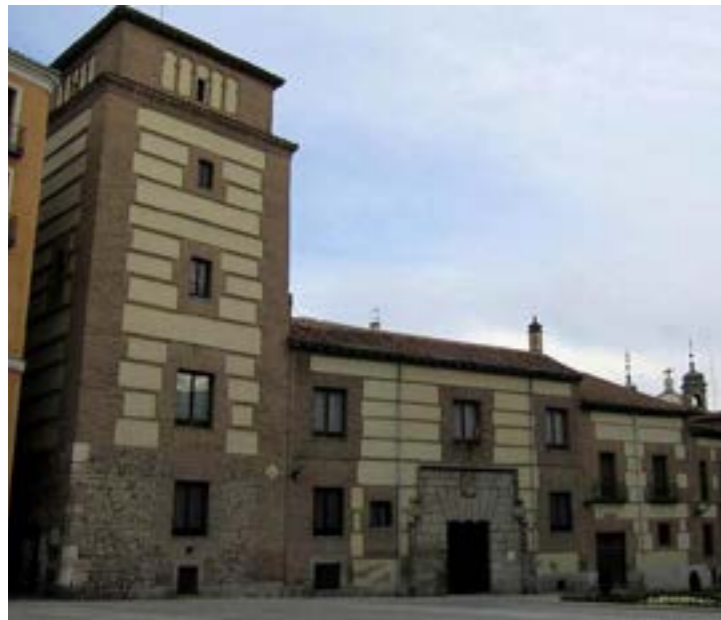
Imagen 30. Torre de los Lujanes, tras la Des-restauración, Actualmente.
