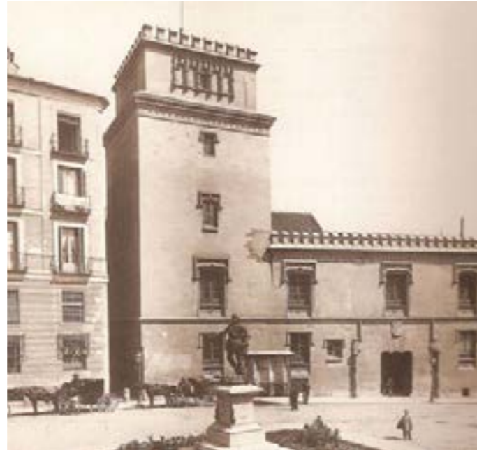
Imagen 29. Torre de los Lujanes, tras la Restauración, 1880.
