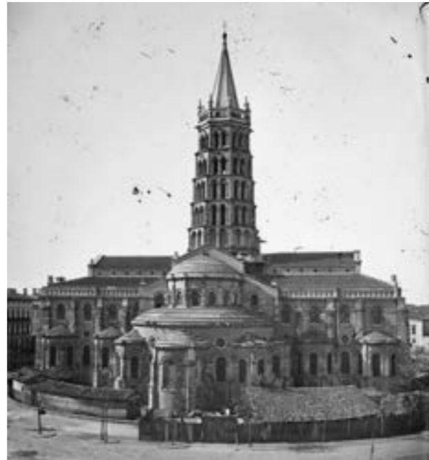
Imagen 23. Ábside de la Iglesia de St. Sernin, después de la Restauración, 1877.
