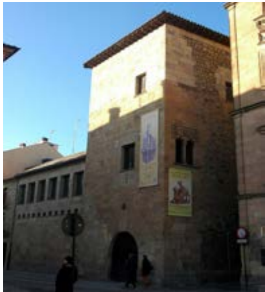
Imagen 48. Torre de los Lujanes, des-restaurada, Actualmente.
