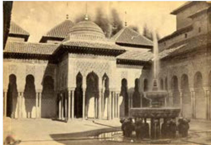
Imagen 40. Pabellón de levante, tras la Restauración de Rafael Contreras.
