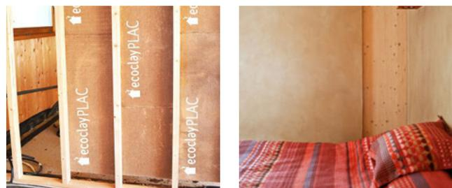
Figura 49. Placas de arcilla ecoclay montaje y acabado. 2018. [www.ecoclay.es](http://www.ecoclay.es).
