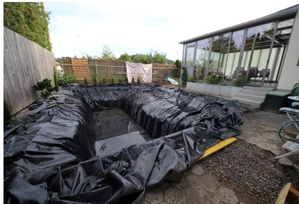
Figura 35. Geotextil e impermeabilización de la piscina. 2015. [www.davidwolfe.com](http://www.davidwolfe.com).
