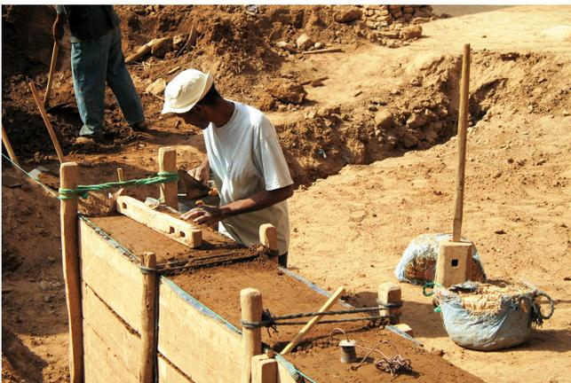
Figura 42. Ejecución del muro de tapia(1).2016.www.terrachidia.es.
