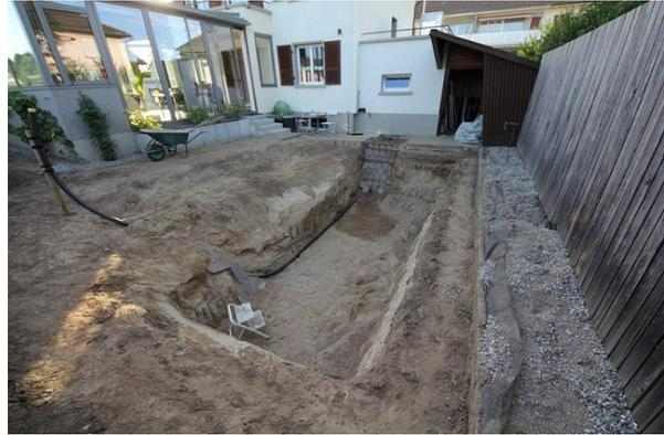
Figura 34. Replanteo y excavación de la piscina. 2015. [www.davidwolfe.com](http://www.davidwolfe.com).
