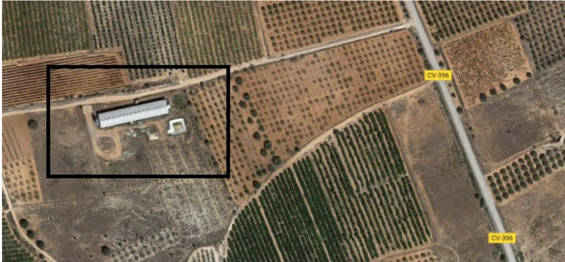
FIGURA 1. LOCALIZACIÓN DE LA INSTALACIÓN
