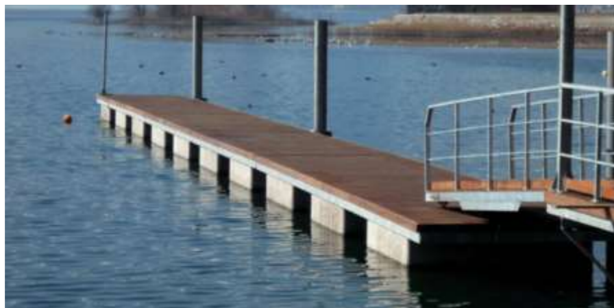
Figura 11. Pantalán de hormigón flotante
