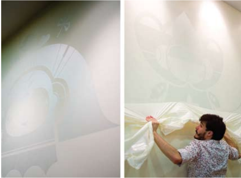
Fig. 69 - Colocación de los vinilos sobre las paredes por personal especializado.
