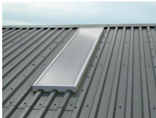
Ilustración 36. Lucernario instalado en cubierta. Fuente: Google Imágenes
