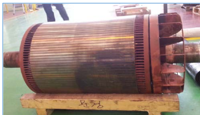
Fig.16. Rozamiento estator-rotor en motor de 6,6 kV y 800 kW con excentricidad.
