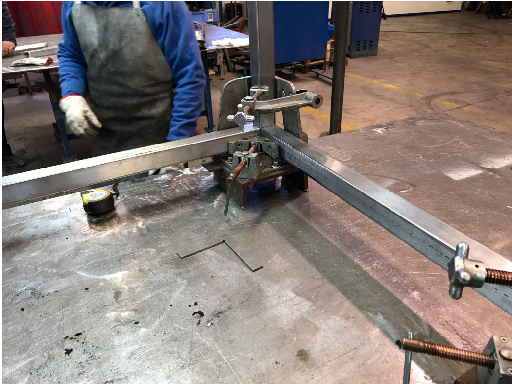
Imagen 11. Posicionamiento a escuadra de “Estructura 50x50x2”
