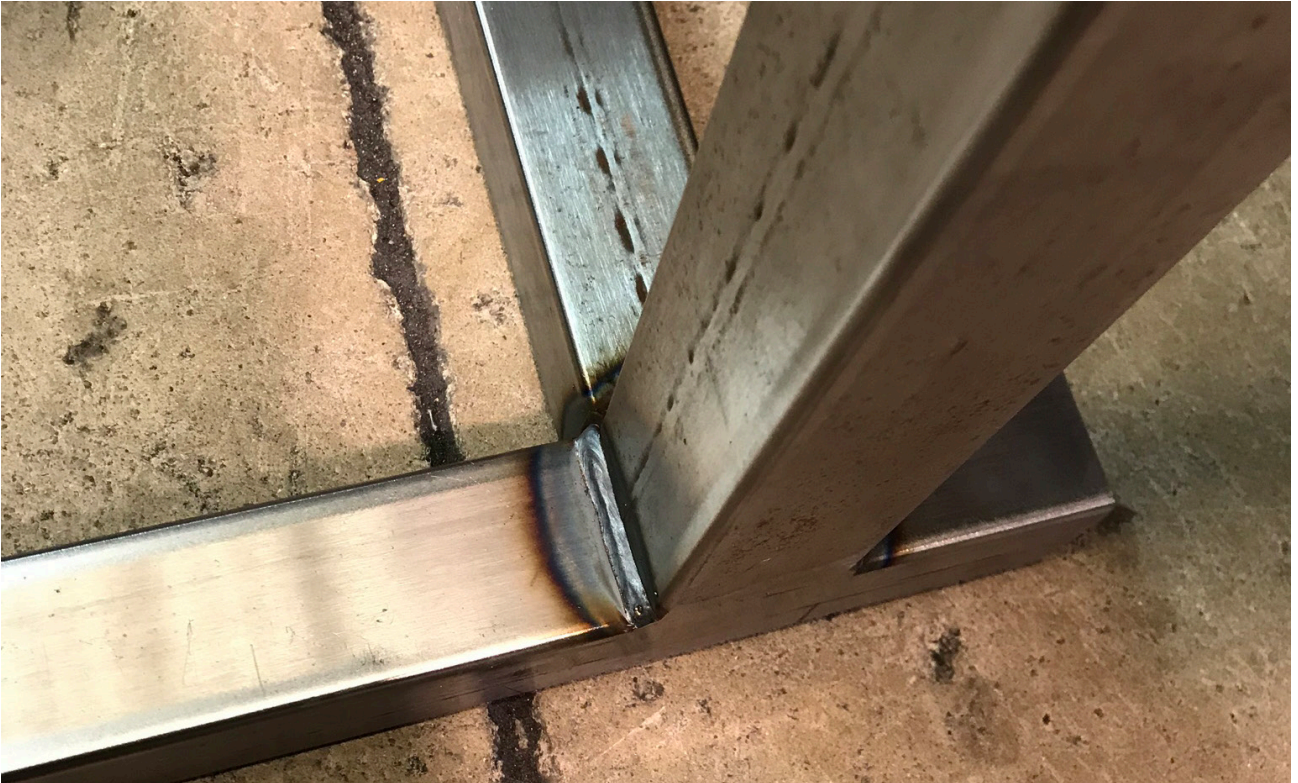
Imagen 17. Cordón soldadura de “Estructura 50x50x2”
