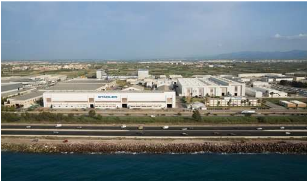
Figura 1: Fotografía aérea de la empresa Stadler Rail Valencia S.A.U
