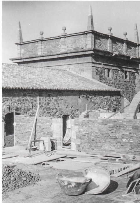
Fig. 42 - Cubierta durante la restauración (AMP).
