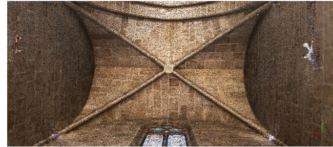
Fig. 110 - Vistas modelo 3D plementería realizadas con PhotoScan.
