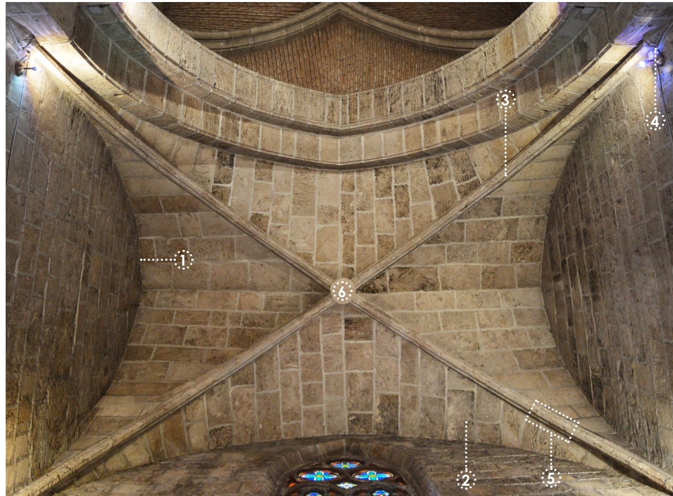
Fig. 14 - Bóveda de la capilla de la Merced, iglesia de Santa María de El Puig.
