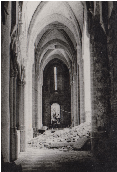
Fig. 46 - Vista de la nave lateral derecha, desde la entrada a la capilla de la Merced, durante la restauración de 1968 (AMP).
