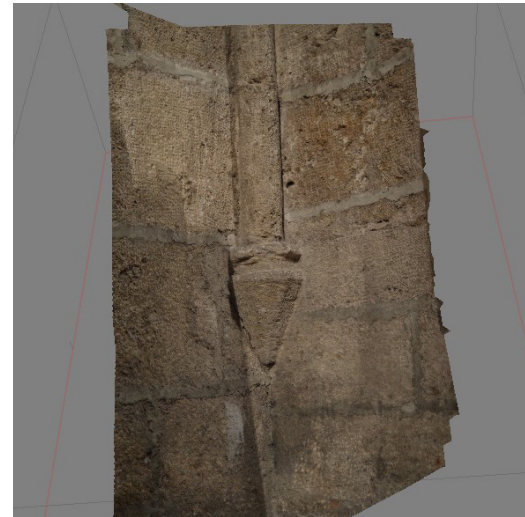
Fig. 79 - Modelo 3D, mensula izquierda, generado con PhotoScan.
