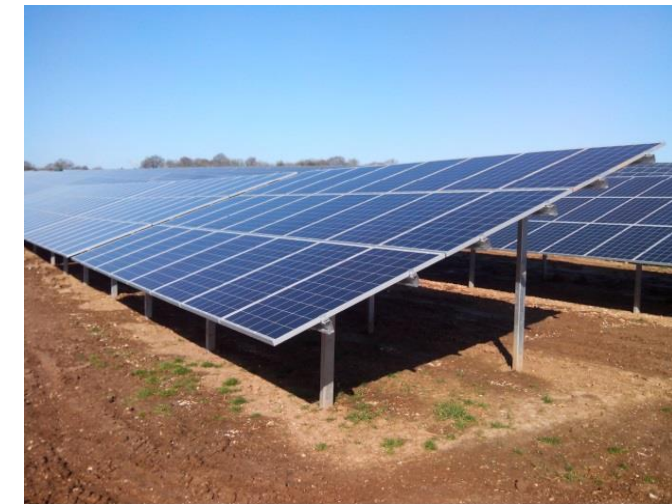
Figuras 12 y 13. Soporte fijo para módulos fotovoltaicos. Fuente: Nclave, S.L.
