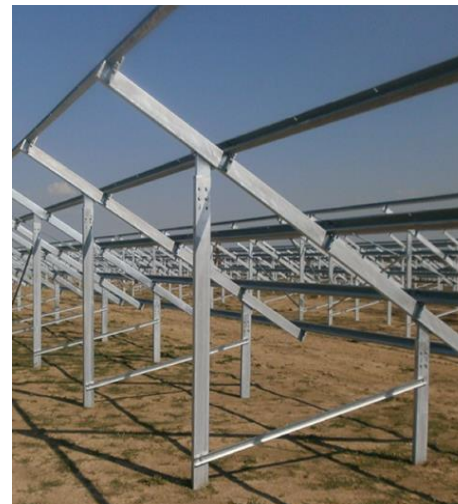
Figuras 12 y 13. Soporte fijo para módulos fotovoltaicos. Fuente: Nclave, S.L.
