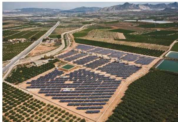
Figura 18. Planta solar conectada a red construida sobre suelo. Fuente: Enerficaz, S.L.
