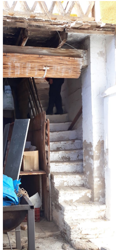
Figura 12. Escalera de acceso a la azotea transitable 2018 Fuente: Propia
