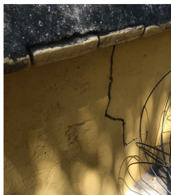
Figura 26. Casetón escalera acceso azotea transitable 2018 Fuente: Propia
