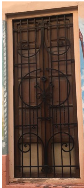
Figura 22. Reja ventana fachada principal 2018 Fuente: Propia
