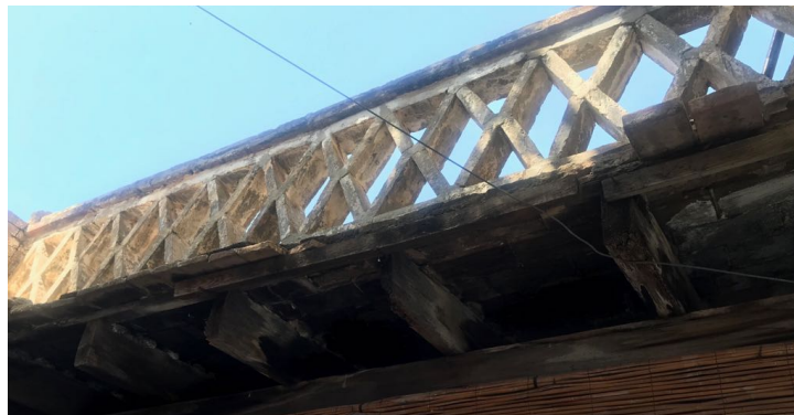
Figura 25. Forjado azotea transitable 2018 Fuente: Propia
