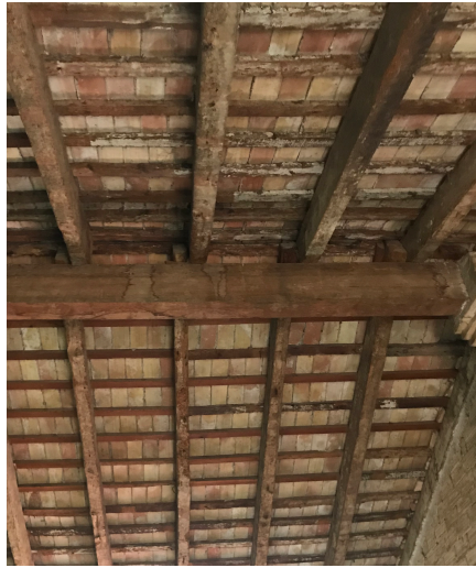
Figura 19. Detalle cara interior cubierta inclinada vivienda 2018 Fuente: Propia
