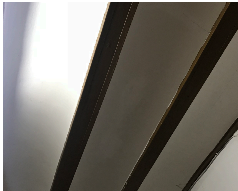
Figura 17. Forjado horizontal vivienda 2018 Fuente: Propia
