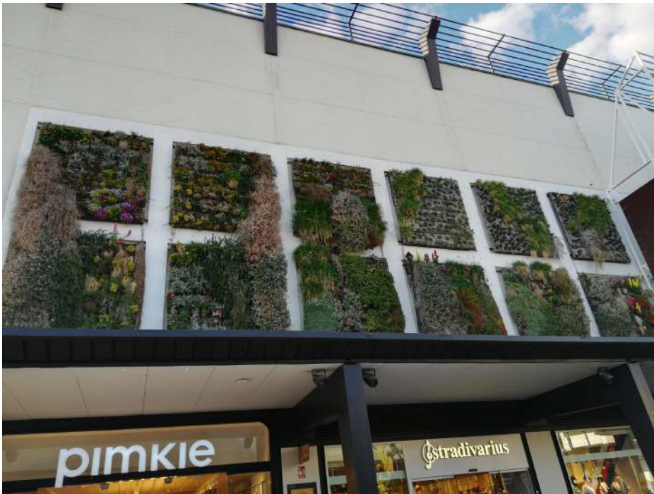
Imagen 45. Ejemplo Fachada vegetal sistema Babylon (Centro comercial Bonaire (Valencia)).
