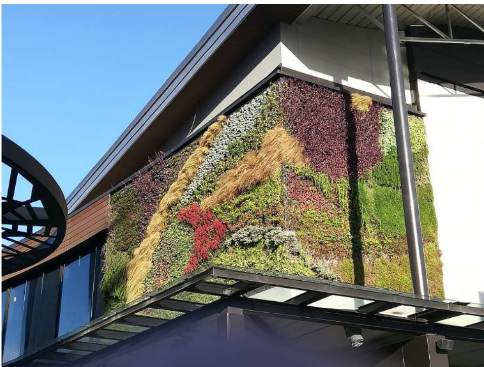
Imagen 46. Ejemplo Fachada vegetal sistema Babylon (Centro comercial Bonaire (Valencia)).
