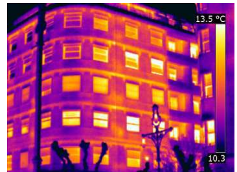
Imagen 12. Termografía de una fachada.
