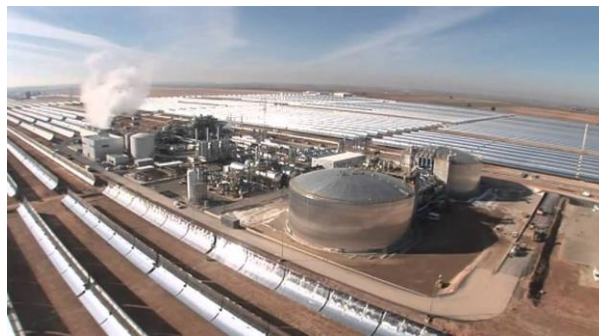
Imagen 5. Tanques de almacenamiento de la central de Manchasol
