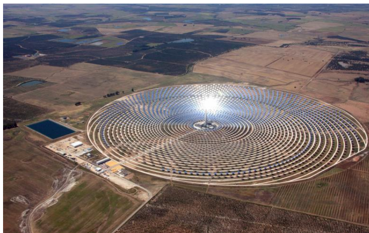
Imagen 1. Central de torre Gemasolar
