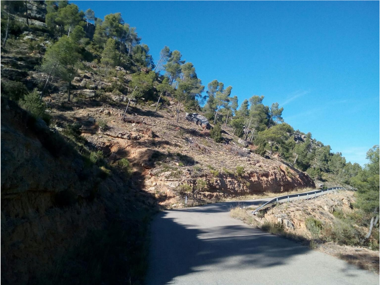
1. Cortafuego apoyado en la carretera.
