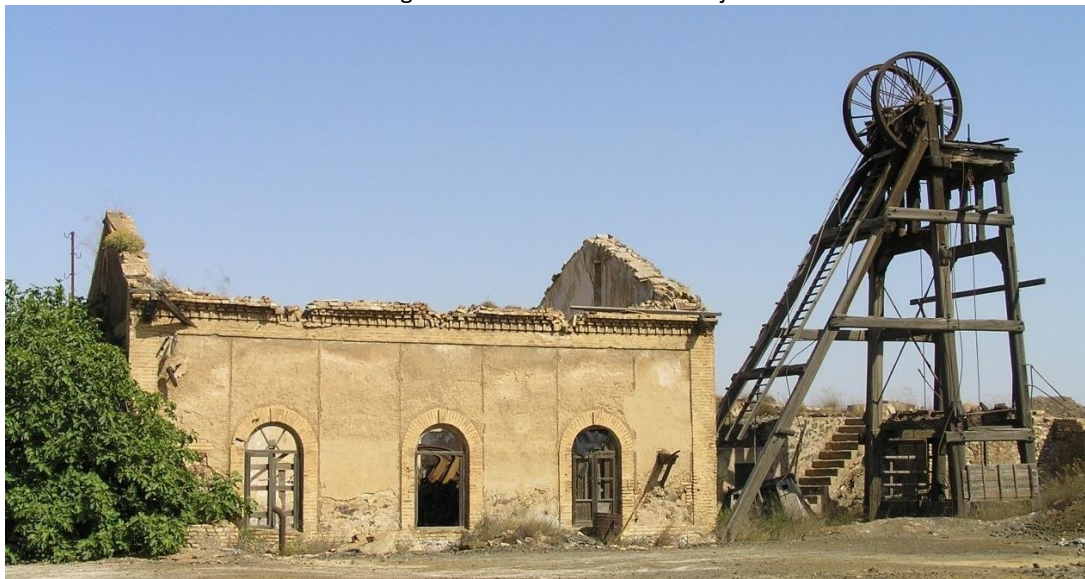
Fotografía 6. Detalle Castillete y casa de máquinas
