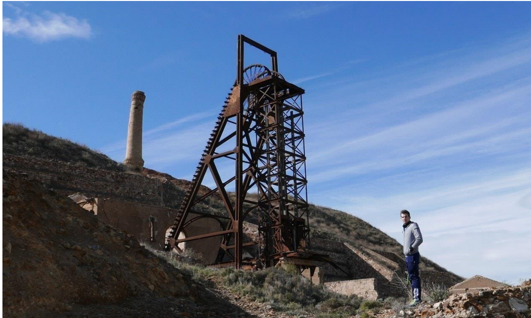
Fotografía 7. Detalle castillete, casa máquinas y chimenea. Mina Montserrat
