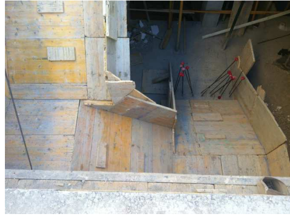
Ejecución del encofrado de la escalera.
