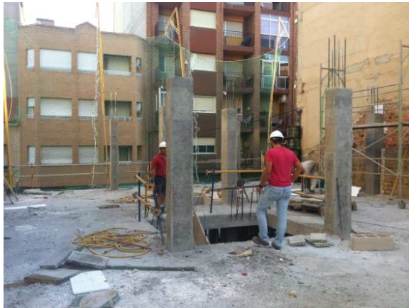
Colocación del armado de la escalera.
