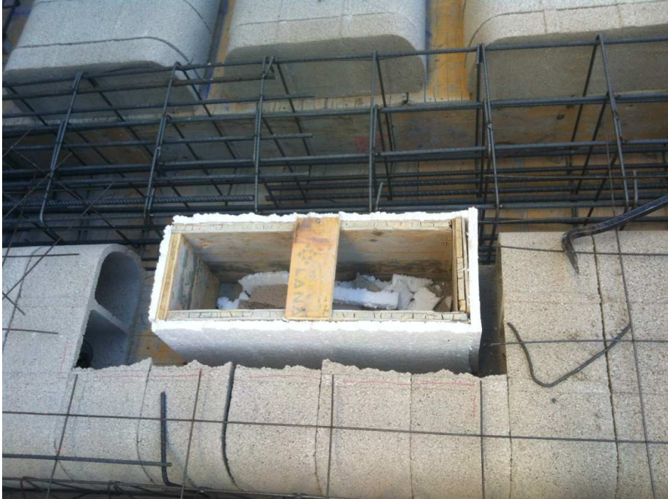
Huevo de instalaciones en bovedilla ya realizado.
