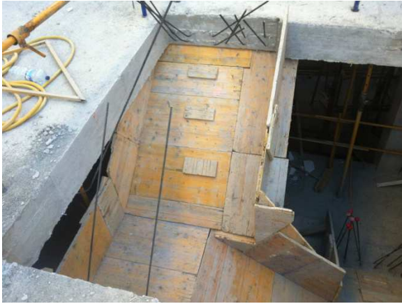
Ejecución del encofrado de la escalera.
