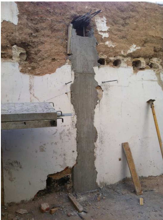
Pilares hormigonados y desencofrados.
