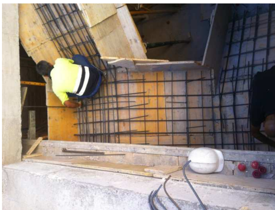
Colocación del armado de la escalera.
