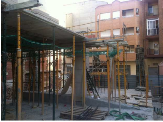
Hormigonado de los pilares de fachada.
