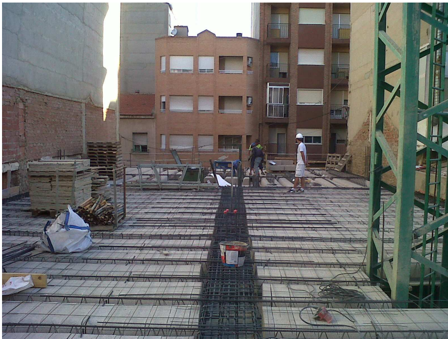
Finalizando la colocación de la armadura en el forjado.
