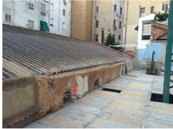
Ejecución del encofrado de madera del forjado 2º.
