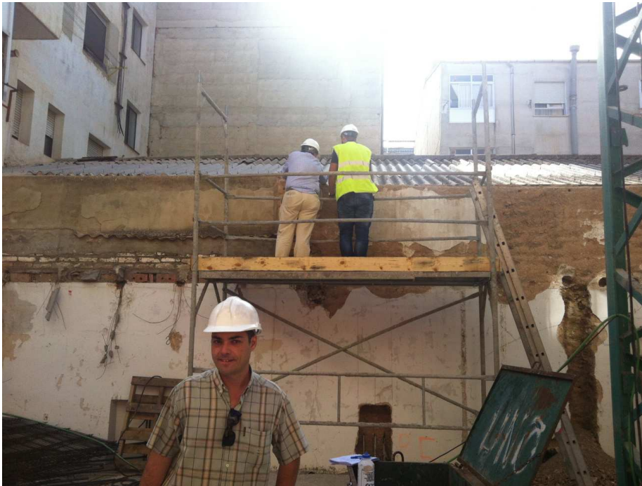
Observación del estado de la medianera colindante con el arquitecto de proyecto y el ingeniero.
