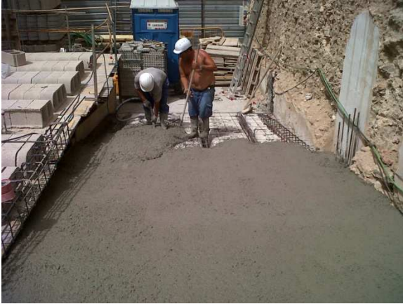
Hormigonado y vibrado de la rampa.
