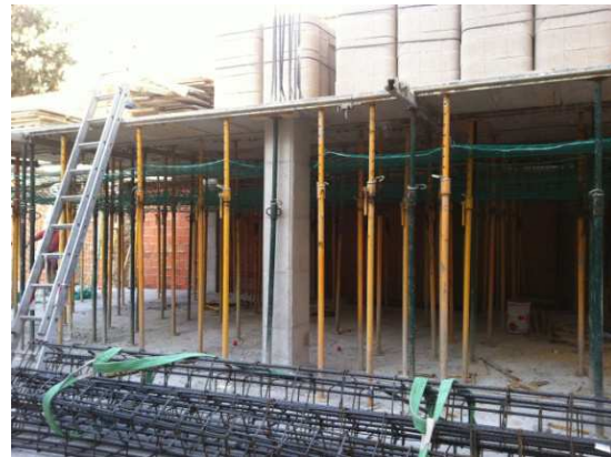
Formación del encofrado del forjado 2º, utilizando las redes de protección.
