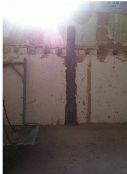
Picado de la medianera para los pilares posteriores.
