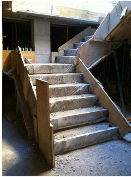
Escalera ya hormigonada.
