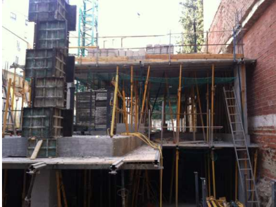
Formación del encofrado del forjado 2º, utilizando las redes de protección.
