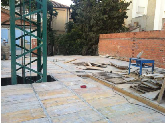
Ejecución del encofrado de madera del forjado 2º.
