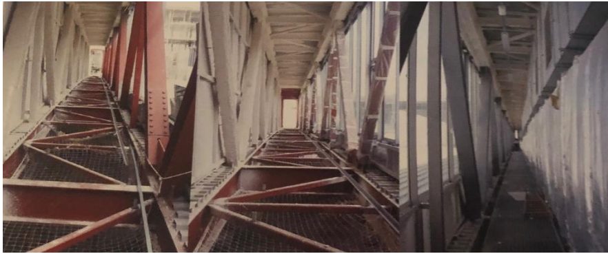
Imagen 5.2. Separación entre celosías.
