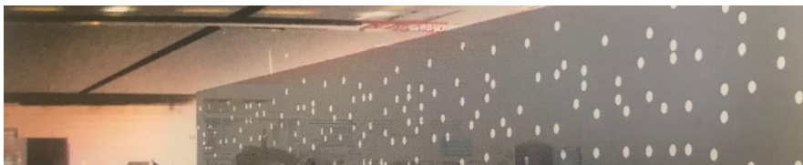
Imagen 2.14. Puerta corredera fachada Este. (7)
