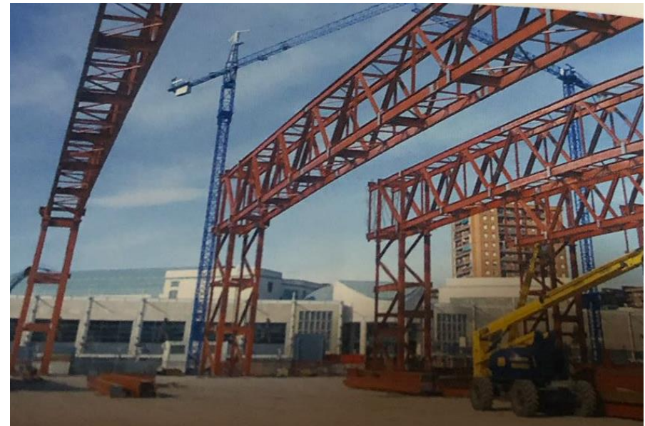
Imagen 3.10. Obra en construcción.
