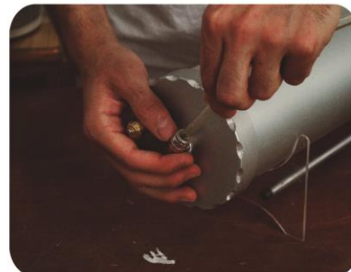
Paso 6: Desconectar el tubo de nylon del depósito
