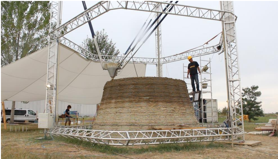
Imagen 16 Construcción de casa de adobe, por Wasp
