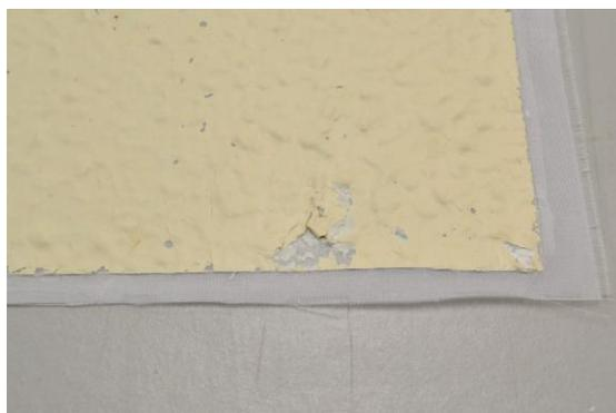
*Ilustración 12. Detalle de levantamiento de pintura por defecto en el refuerzo.*
