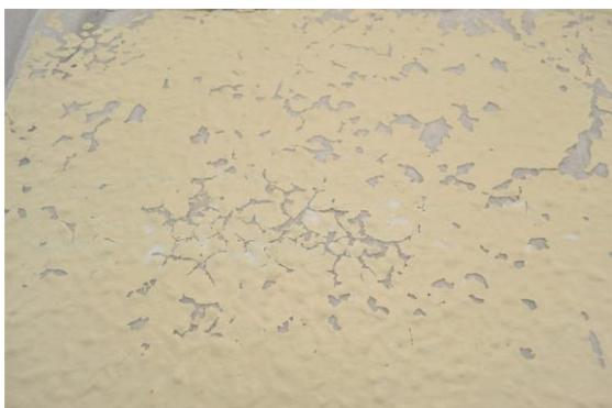
*Ilustración 13. Detalle de imperfecciones en la pintura.*
