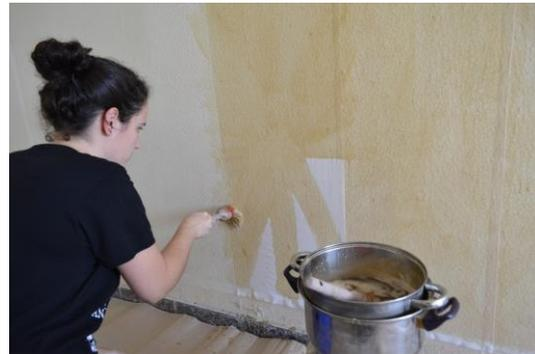
*Ilustración 11. Colocación del primer tejido, gasa.*
