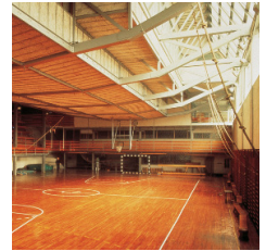
ALEJANDRO DE LA SOTA Gimnasio Colegio Maravillas
