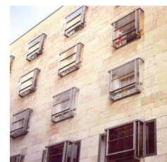
ALEJANDRO DE LA SOTA Bloques de viviendas Prior, Salamanca
