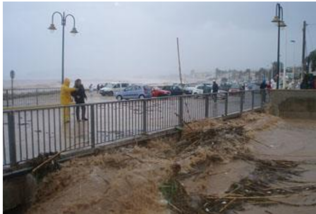
Figura 5. Imagen del puente existente aguas abajo del emplazamiento del proyecto en una crecida del río Gorgos. Fuente: Meteoxàbia.
